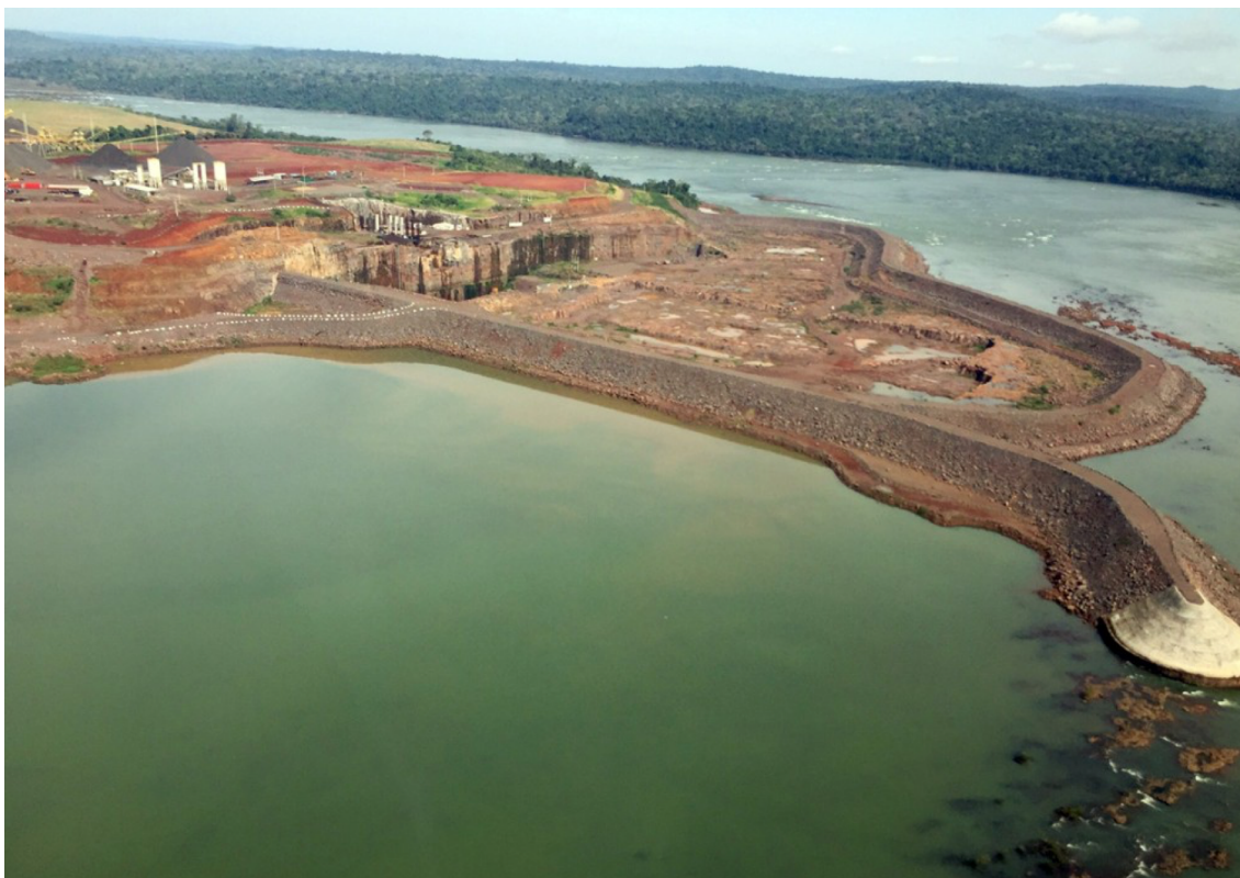
Foto 2: Obras da UHE do Baixo Iguaçu
