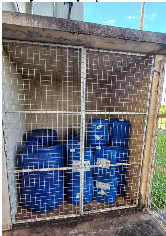
Fotografia 19 - Abrigo temporário de resíduos
