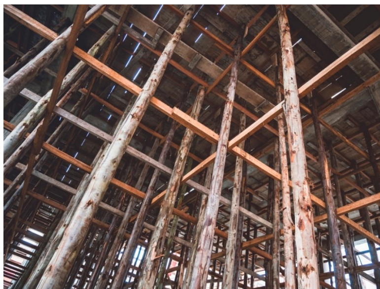
Figura 3 – Escoras em madeira Fonte: Arquivo Pessoal, 2020.
