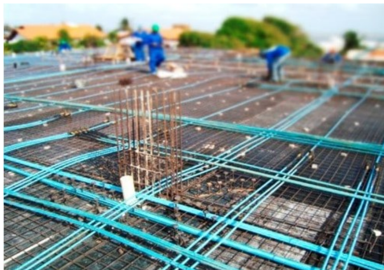
Figura 12 – Laje Maciça em Protensão Fonte: Teres, 2020.
