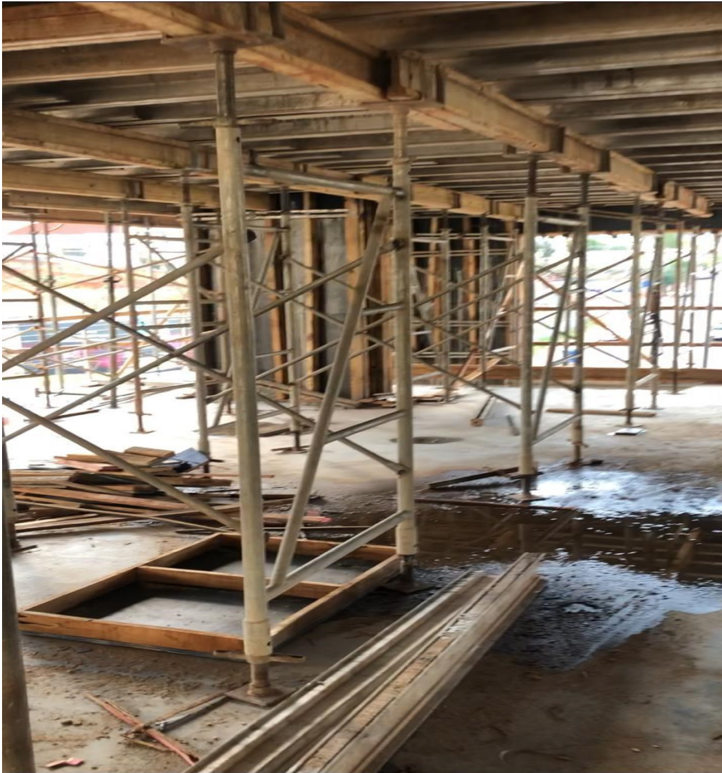
Figura 39 – Acompanhamento da Obra do Projeto 4
