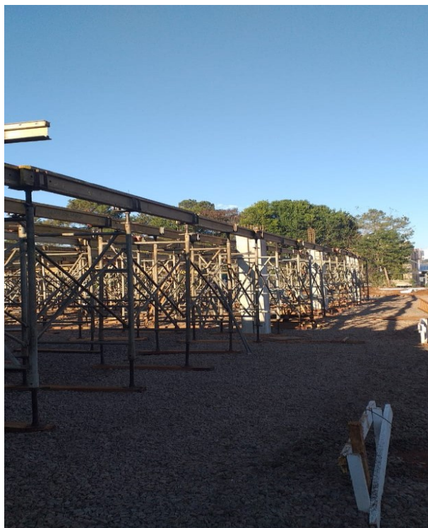
Figura 9 - Montagem Cimbramento Metálico Fonte: Arquivo Pessoal, 2020.
