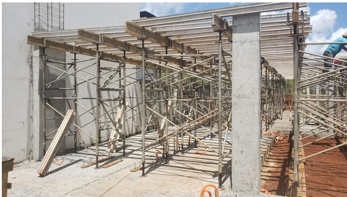
Figura 21 – Acompanhamento da Obra do Projeto 1 Fonte: Próprio Autor, 2021.
