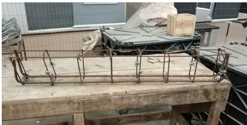
Figura 26 – Armadura Fonte: Autoria Própria (2020).
