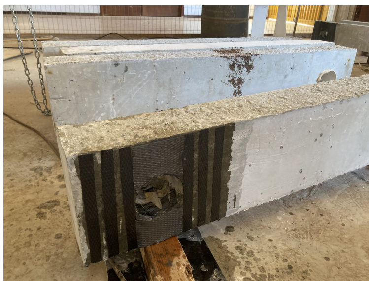
Figura 35 – Mantas coladas na viga Fonte: Autoria Própria (2021).
