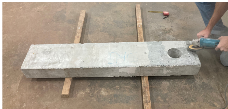
Figura 33 – Retirada da nata de cimento da região onde será colado o reforço em fibra de carbono
