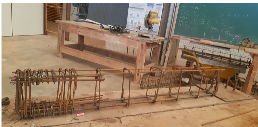
Figura 28 – Montagem das armaduras Fonte: Autoria Própria (2021).
