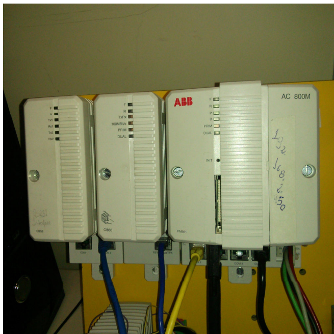
Fotografia 9 - CI853, CI860 e CLP AC800M (ABB) Fonte: Autoria própria
