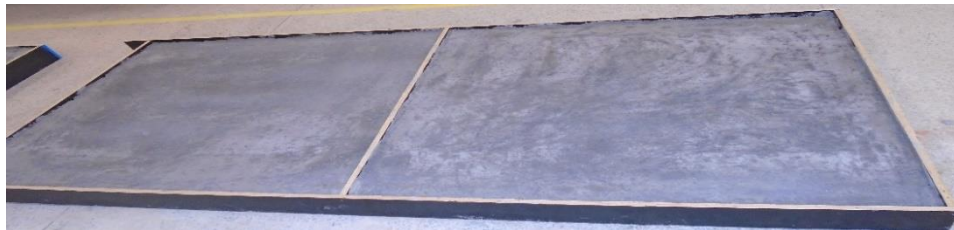
Figura 27 - Painéis com chapisco.
