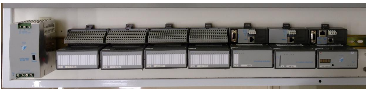
Figura 31 – Fonte, CPU, Módulos do CLP
