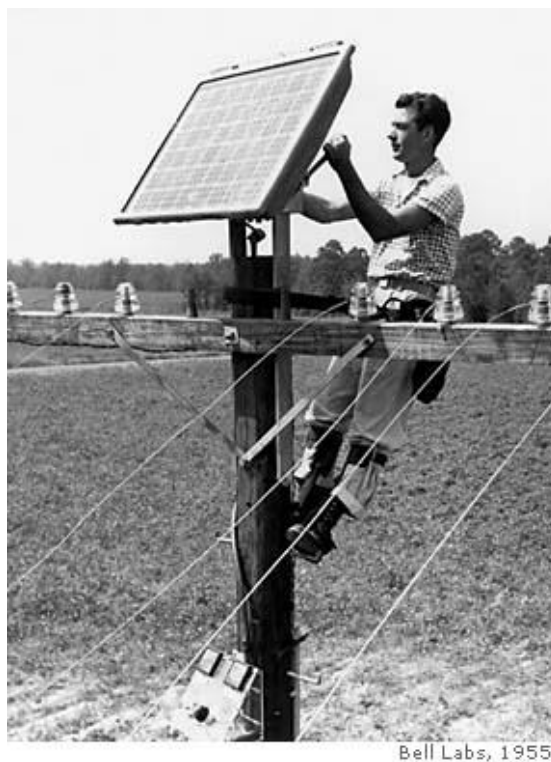
Figura 1: A primeira bateria solar da Bell em Americus, Geórgia.
