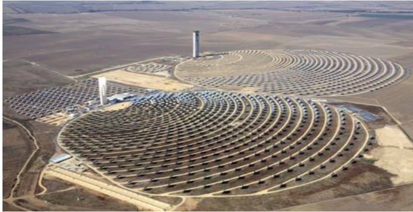
Figura 23- Foto das torres de concentração PS10 e PS20 na Espanha Fonte: ABENGOA (2012)
