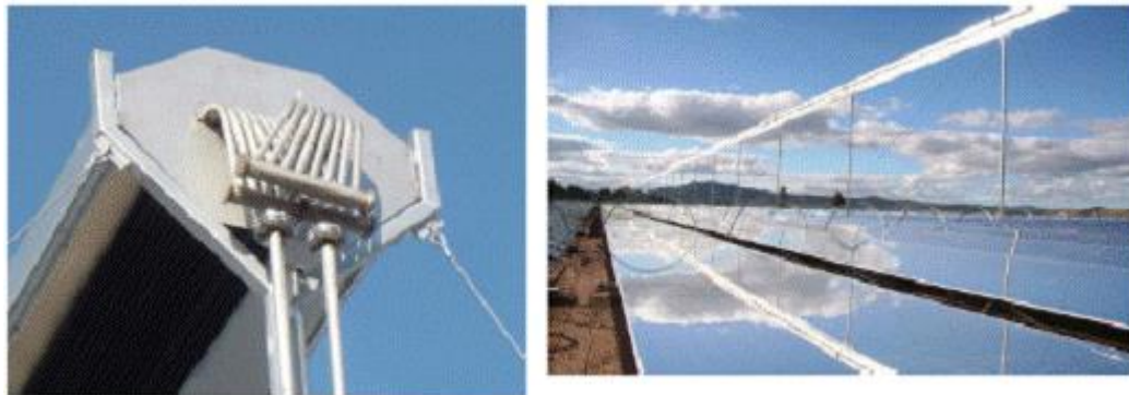
Figura 19 – Refletor Fresnel Fonte: AREVA (2011) apud LODI (2011)
