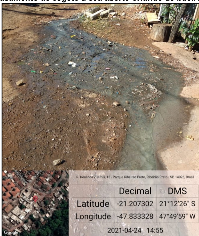
Figura 11 - Extravasamento de esgoto a céu aberto oriundo de bueiro obstruído.
