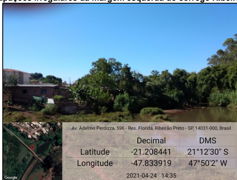
Figura 16 - Ocupações irregulares da margem esquerda do córrego Ribeirão Preto.
