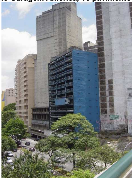
Figura 5 – Edifício Garagem América, 16 pavimentos, São Paulo - SP
