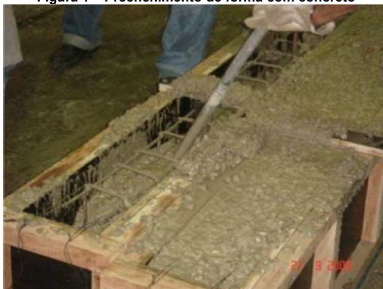
Figura 1 – Preenchimento de fôrma com concreto
