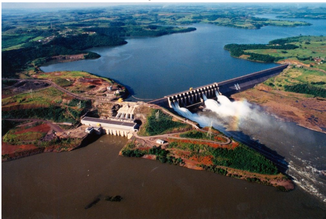
Figura 1 - Usina hidrelétrica Governador José Richa-Salto Caxias - barragem de concreto tipo gravidade
