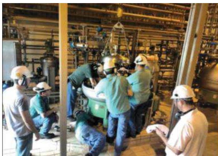
Figura 5 – Equipes de manutenção trabalhando em paralelo. Fonte: Dados da empresa
