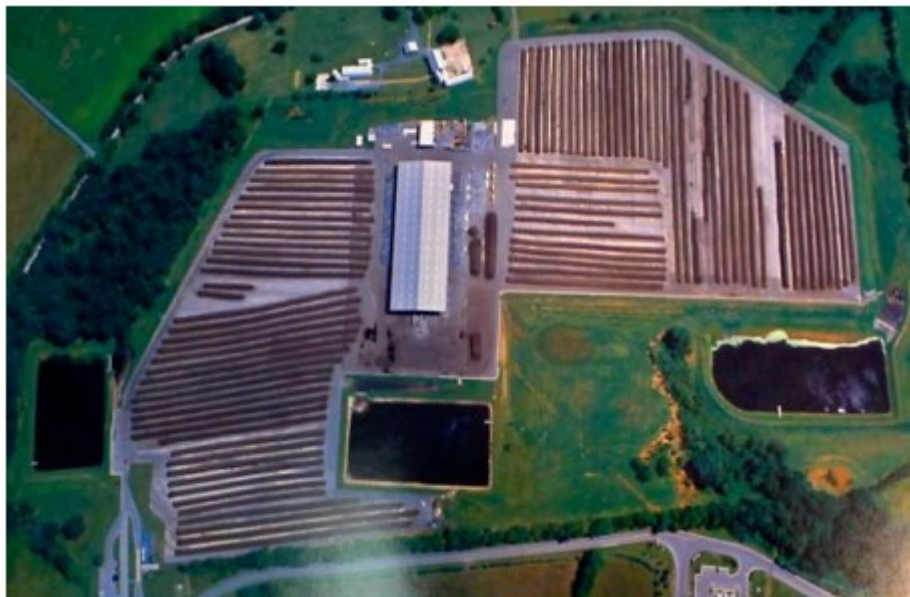
Figura 6 - Vista superior da Unidade de Compostagem do Condado de Montgomery, Maryland – EUA
