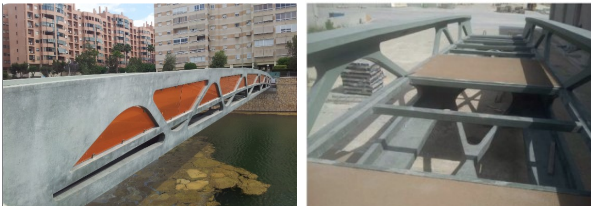
Figura 1 - Passarela de UHPC sobre o Barranco de las Ovejas (Alicante)
