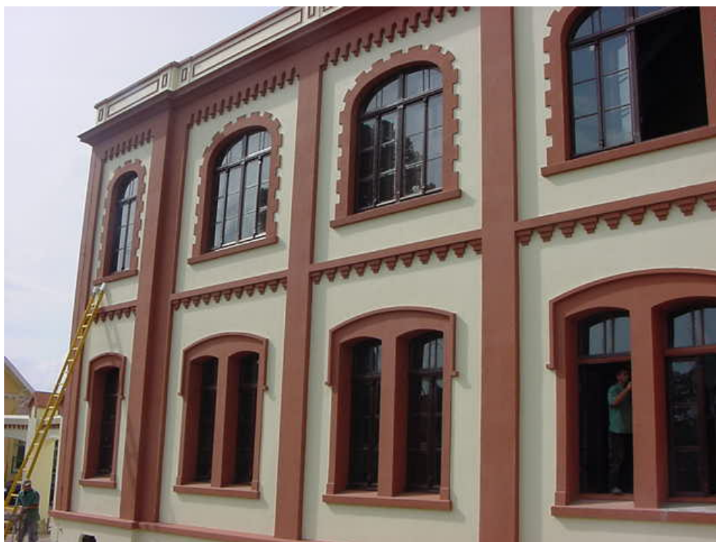
Figura 128: Restauro das esquadrias, portas e janelas - Hospital Psiquiátrico Nossa Senhora da Luz dos Pinhais
