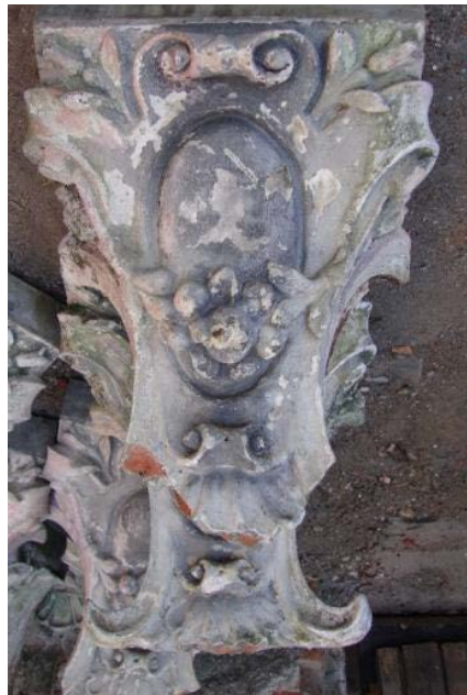
Figura 75: Elemento decorativo retirado para elaboração do molde – Ferragens Hauer
