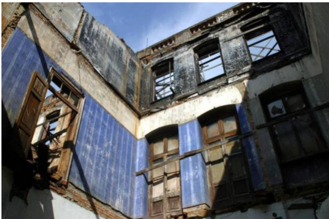
Figura 67: Foto do incêndio – Ferragens Hauer
