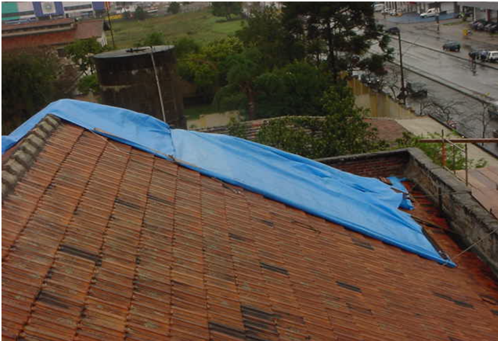
Figura 122: Execução do restauro do telhado - Hospital Psiquiátrico Nossa Senhora da Luz dos Pinhais
