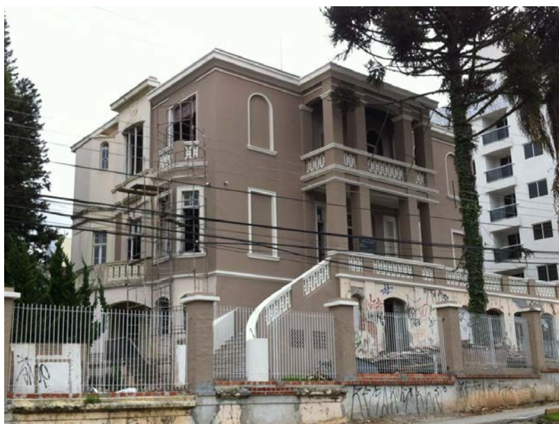
Figura 113: Casa sendo restaurada e adaptada para o novo uso - Residência Vila Sophia
