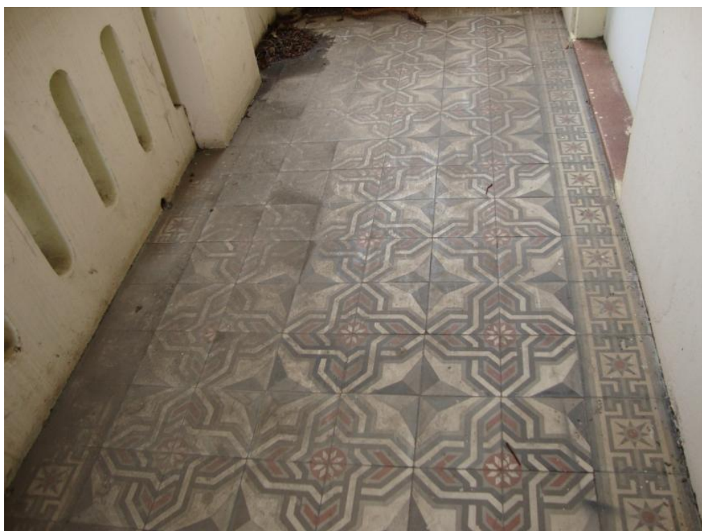
Figura 95: Restauro do ladrilho hidráulico da entrada- Residência Vila Sophia Fonte: Autor.
