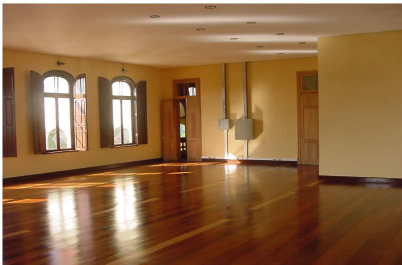
Figura 138: Adaptação do novo uso, adaptação de pisos, forros e instalações - Hospital Psiquiátrico Nossa Senhora da Luz dos Pinhais
