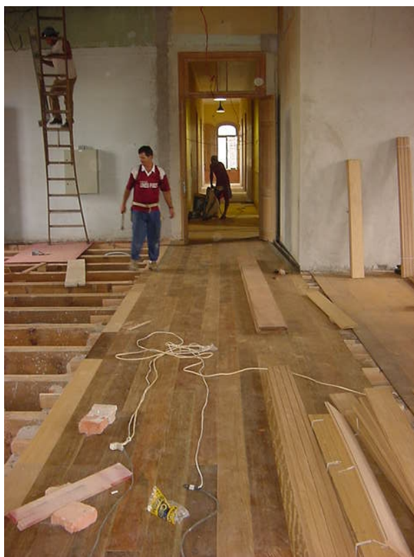
Figura 129: Adaptação do edifício ao novo uso, troca de piso do auditório - Hospital Psiquiátrico Nossa Senhora da Luz dos Pinhais
