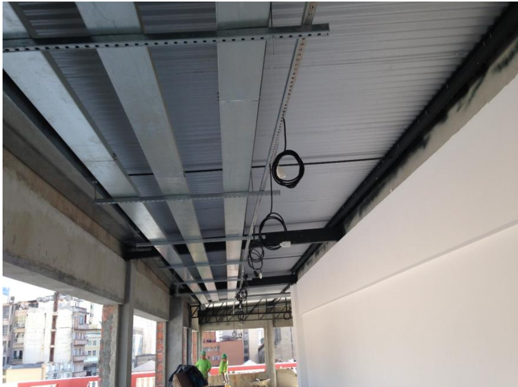
Figura 80: Adaptação elétrica para o novo uso – Ferragens Hauer Fonte: Autor.
