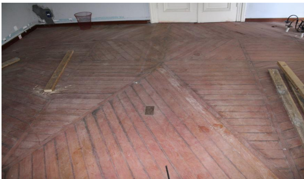
Figura 94: Restauro dos pisos do pavimento Térreo - Residência Vila Sophia Fonte: Autor
