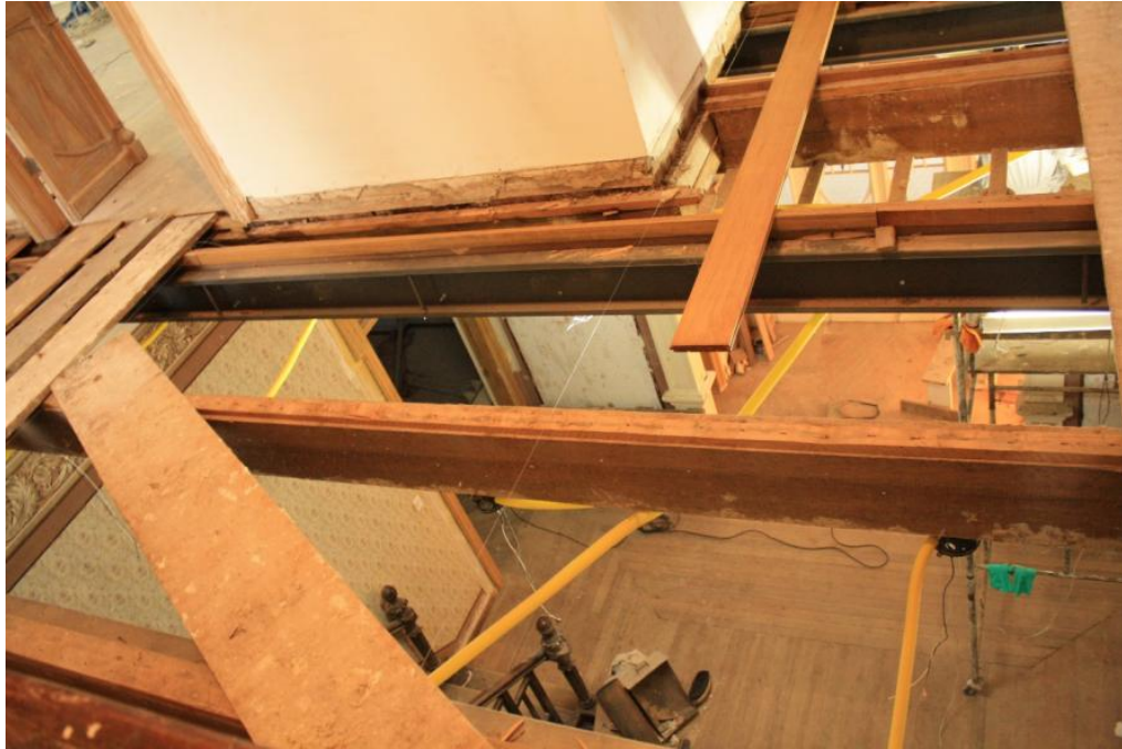
Figura 108: Restauro do piso superior comprometido - Residência Vila Sophia Fonte: Autor a partir de Conejos (2011).
