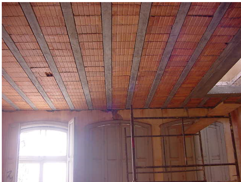
Figura 146: Reforço estrutural, execução de laje intermediária - Hospital Psiquiátrico Nossa Senhora da Luz dos Pinhais Fonte: Autor.
