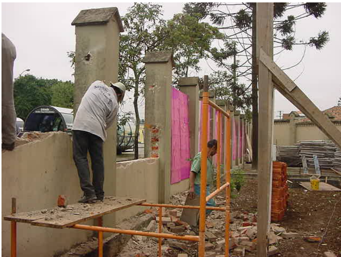
Figura 143: Recomposição do muro frontal conforme o original - Hospital Psiquiátrico Nossa Senhora da Luz dos Pinhais
