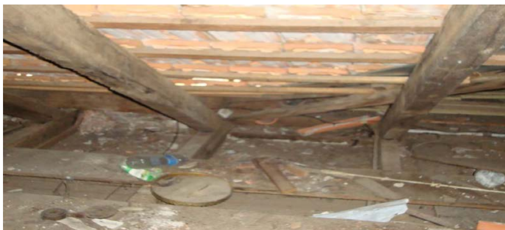
Figura 93: Restauro do telhado, troca de estruturas - Residência Vila Sophia Fonte: Autor.
