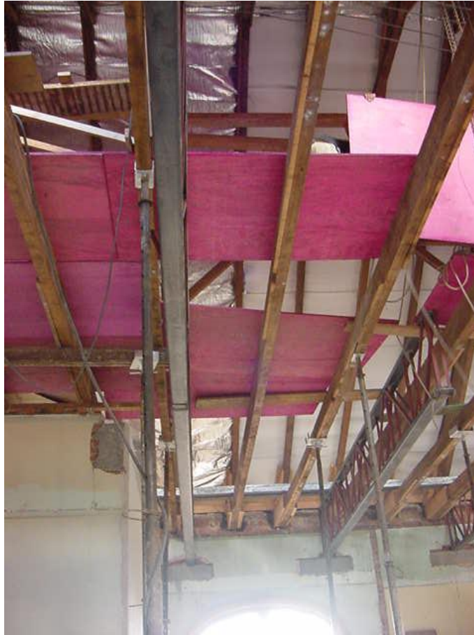
Figura 145: Reforço estrutural, treliças metálicas - Hospital Psiquiátrico Nossa Senhora da Luz dos Pinhais Fonte: Autor.
