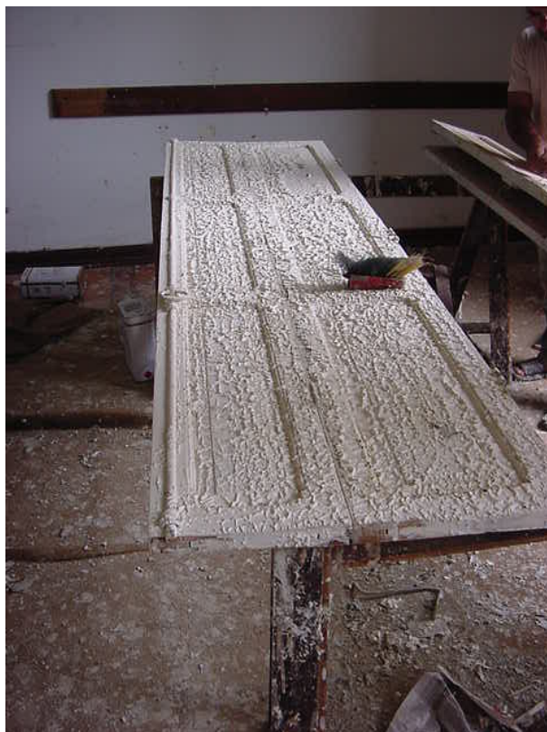
Figura 127: Restauro das esquadrias, portas e janelas - Hospital Psiquiátrico Nossa Senhora da Luz dos Pinhais
