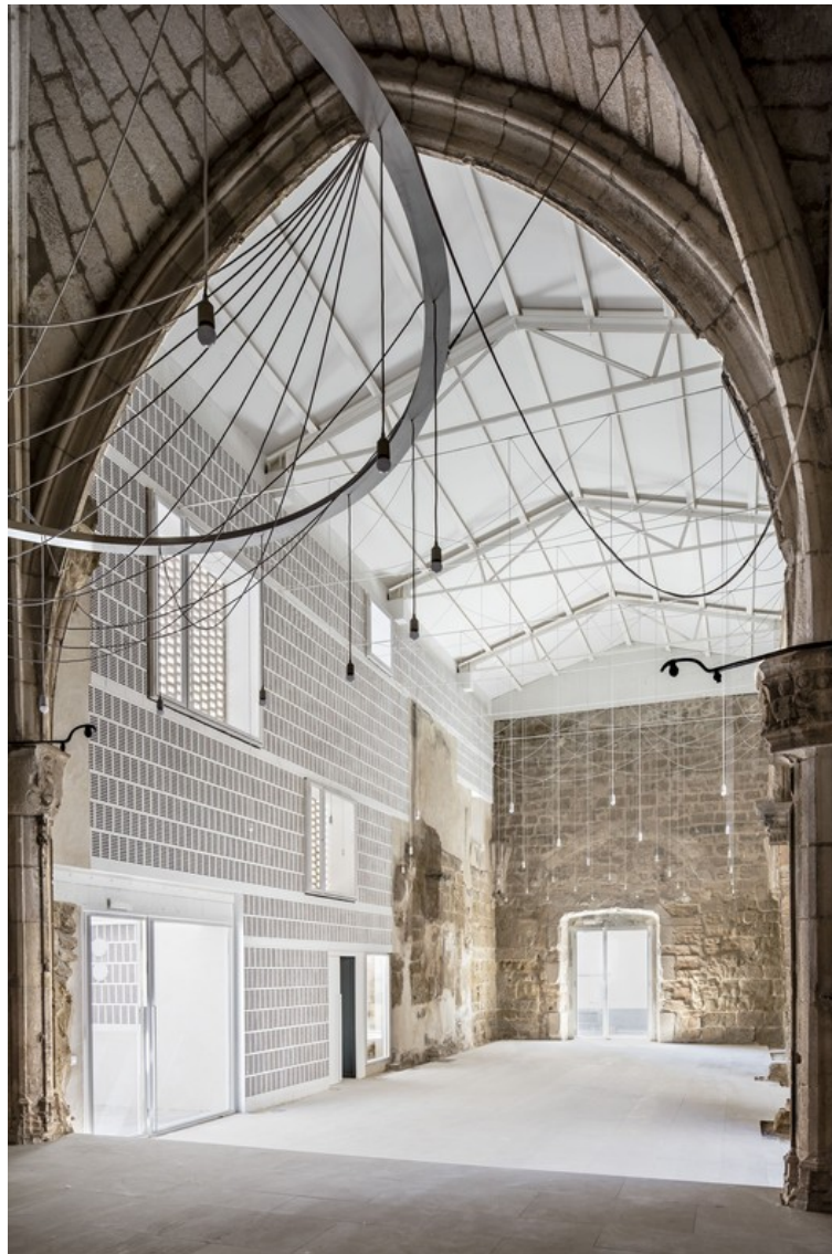
Figura 32: Reestruturação do telhado - Santa María de Vilanova de la Barca.
