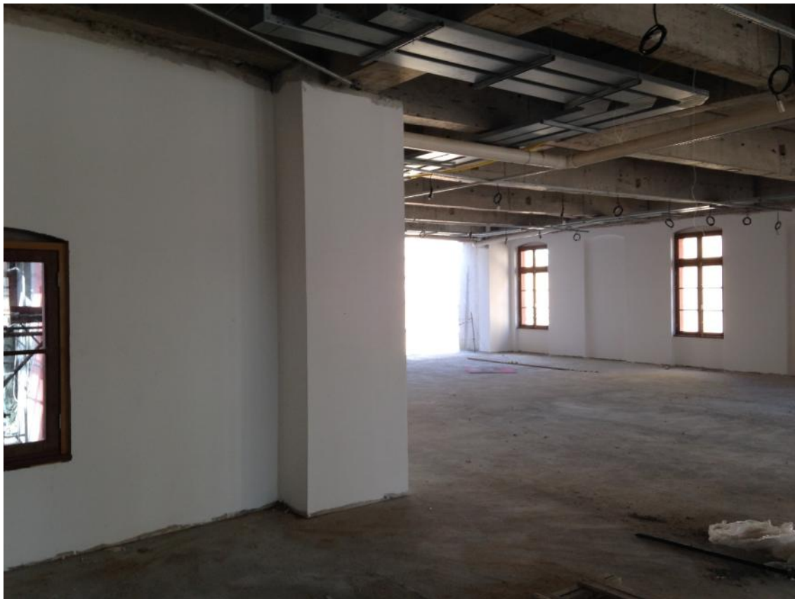
Figura 82: Utilização de lajes de concreto e estruturas com pouco fator de reversibilidade – Ferragens Hauer
