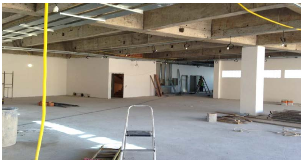
Figura 86: Nova estrutura colocação de escadas de emergência – Ferragens Hauer
