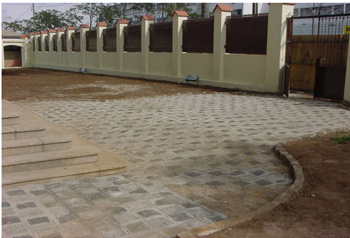
Figura 144: Muro restaurado - Hospital Psiquiátrico Nossa Senhora da Luz dos Pinhais
