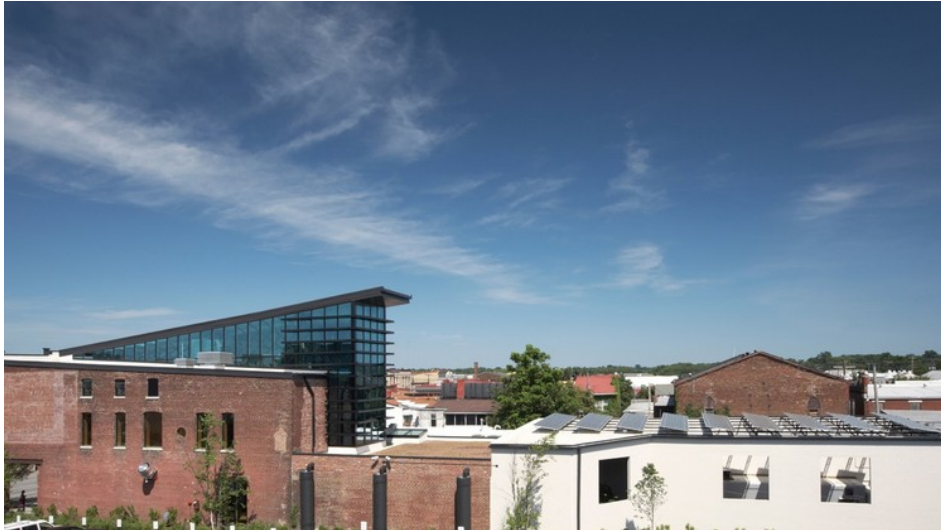
Figura 3: Adaptação ao entorno da edificação – Estúdio Green Fonte: The Green Building / (fer) studio ", (2011).
