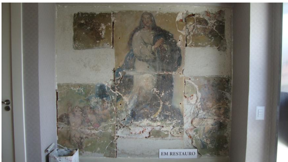
Figura 101: Colocação da imagem em novo local no interior da casa - Residência Vila Sophia Fonte: Autor.
