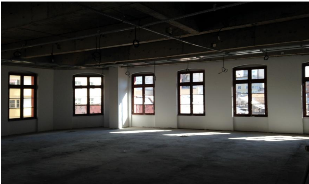
Figura 84: Restauração das esquadrias de madeira conforme originais – Ferragens Hauer
