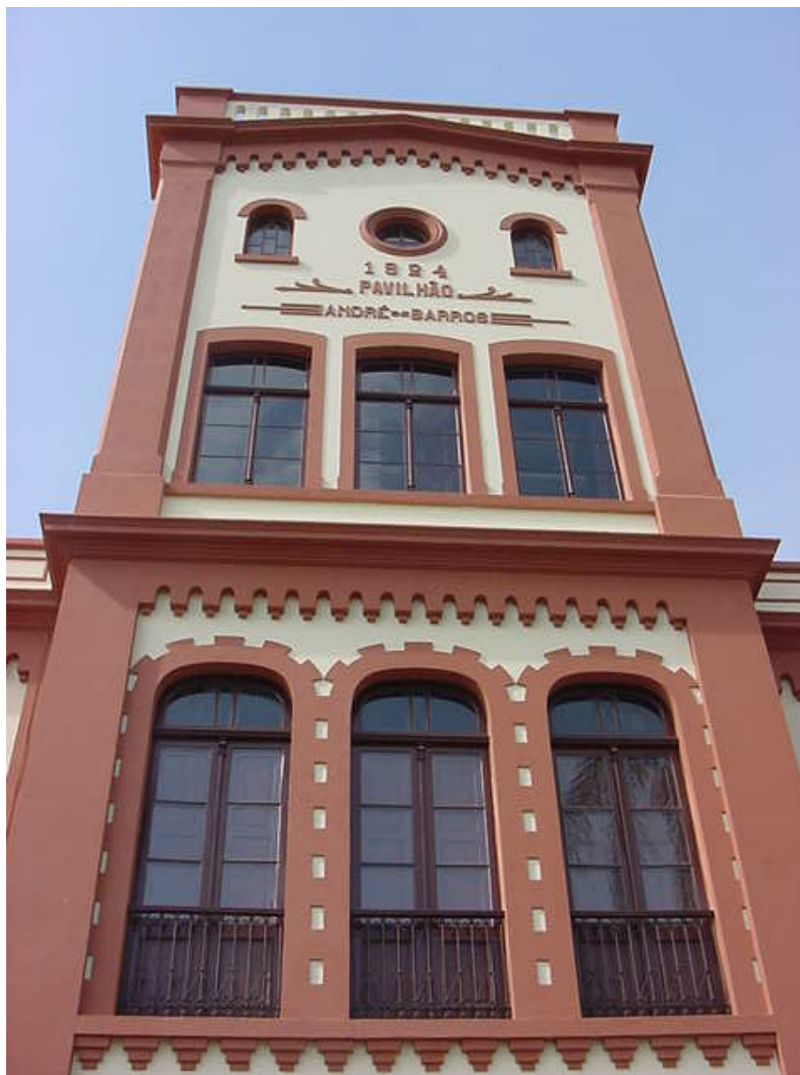
Figura 142: Fachada restaurada - Hospital Psiquiátrico Nossa Senhora da Luz dos Pinhais
