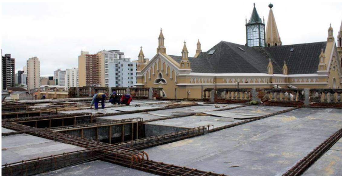
Figura 73: Concretagem da laje para travamento da edificação – Ferragens Hauer Fonte: Autor.
