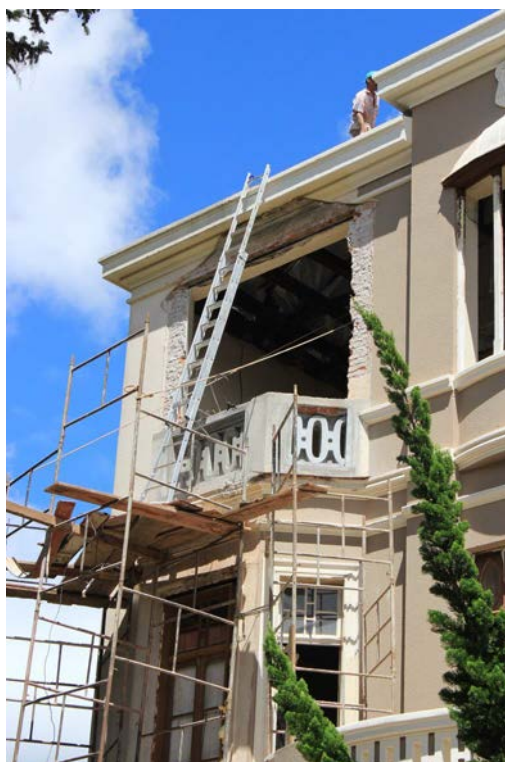
Figura 99: Retirada da imagem de pintura parietal de Nossa Senhora - Residência Vila Sophia Fonte: Autor
