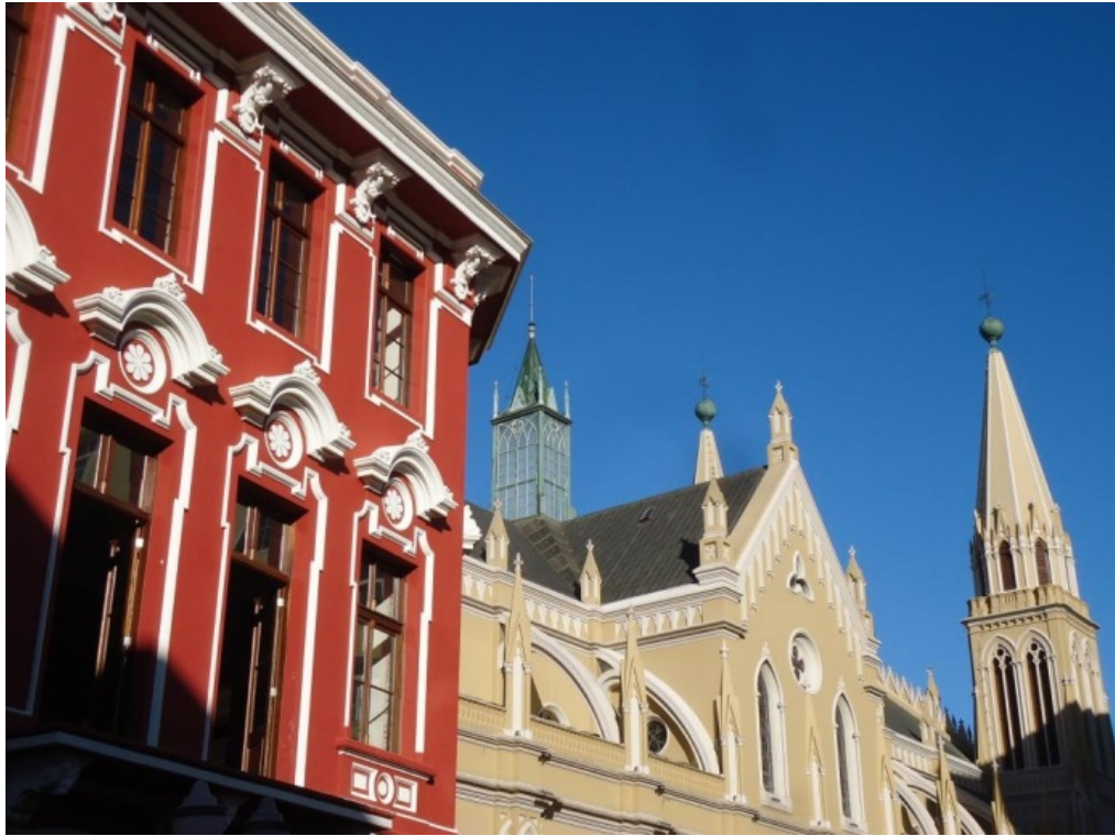
Figura 78: Fachada restaurada em contraste com a catedral – Ferragens Hauer Fonte: Autor.
