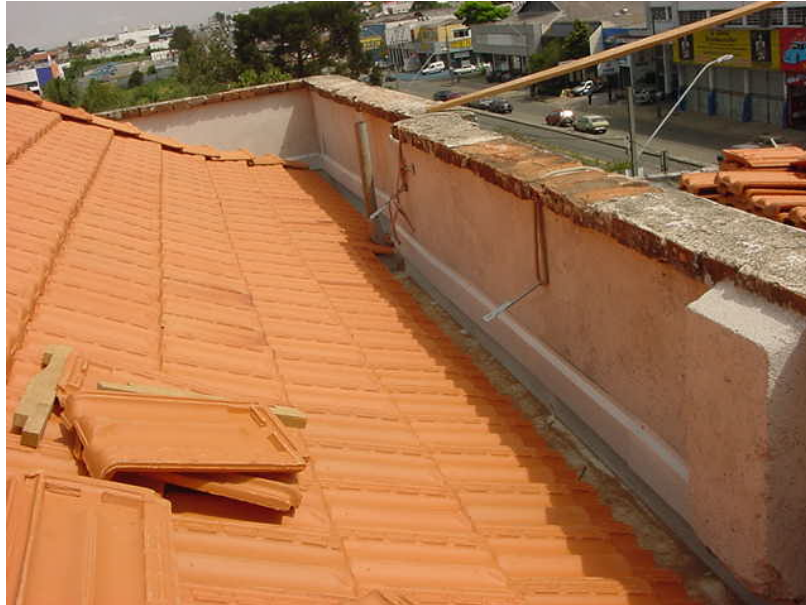
Figura 124: Execução do restauro do telhado - Hospital Psiquiátrico Nossa Senhora da Luz dos Pinhais
