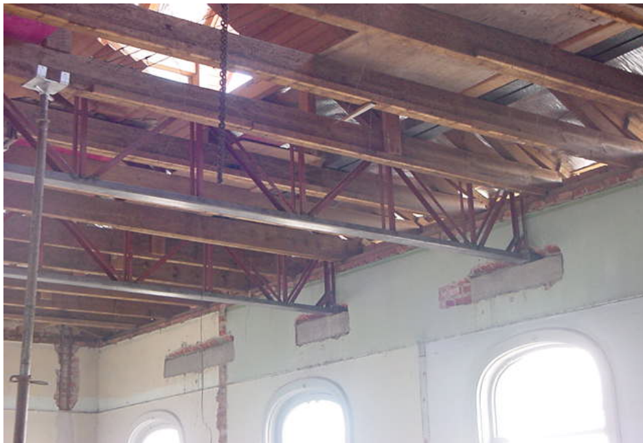
Figura 137: Adaptação do edifício ao novo uso, colocação de estrutura metálica para execução de auditório - Hospital Psiquiátrico Nossa Senhora da Luz dos Pinhais
