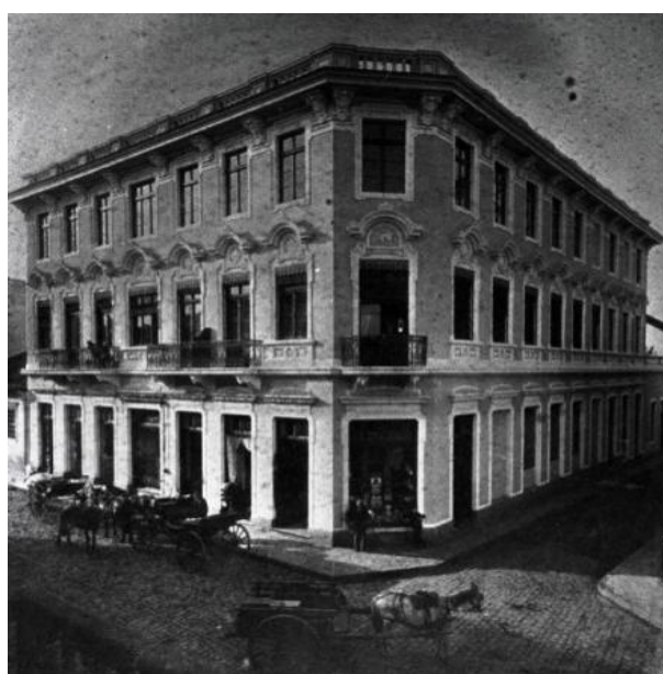
Figura 61: Foto da edificação – Ferragens Hauer Fonte: Gazeta do Povo (1989).
