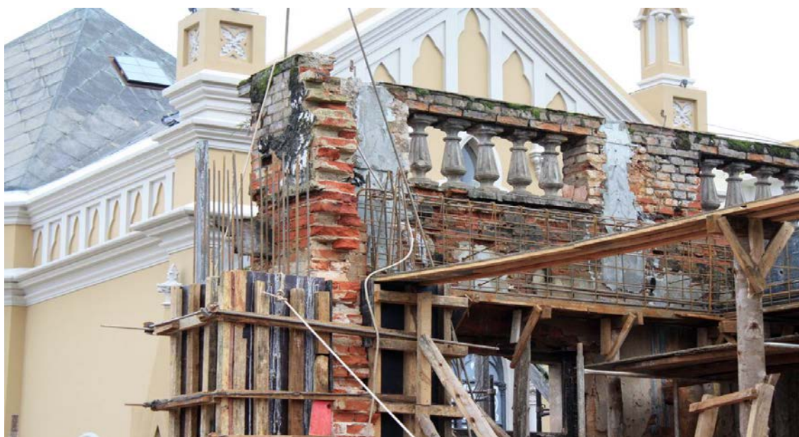
Figura 72: Engaste dos novos pilares na fachada histórica – Ferragens Hauer
