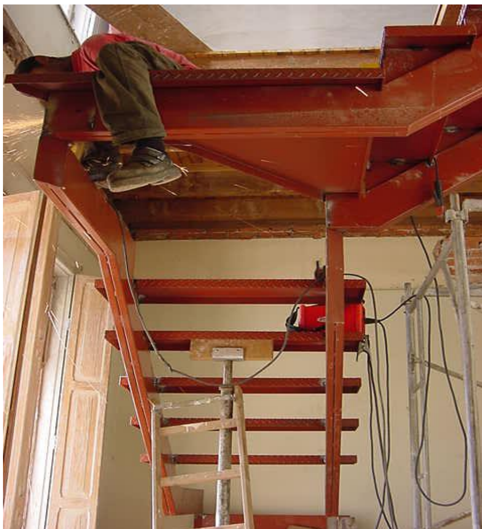
Figura 135: Adaptação do edifício ao novo uso, execução de escada metálica - Hospital Psiquiátrico Nossa Senhora da Luz dos Pinhais
