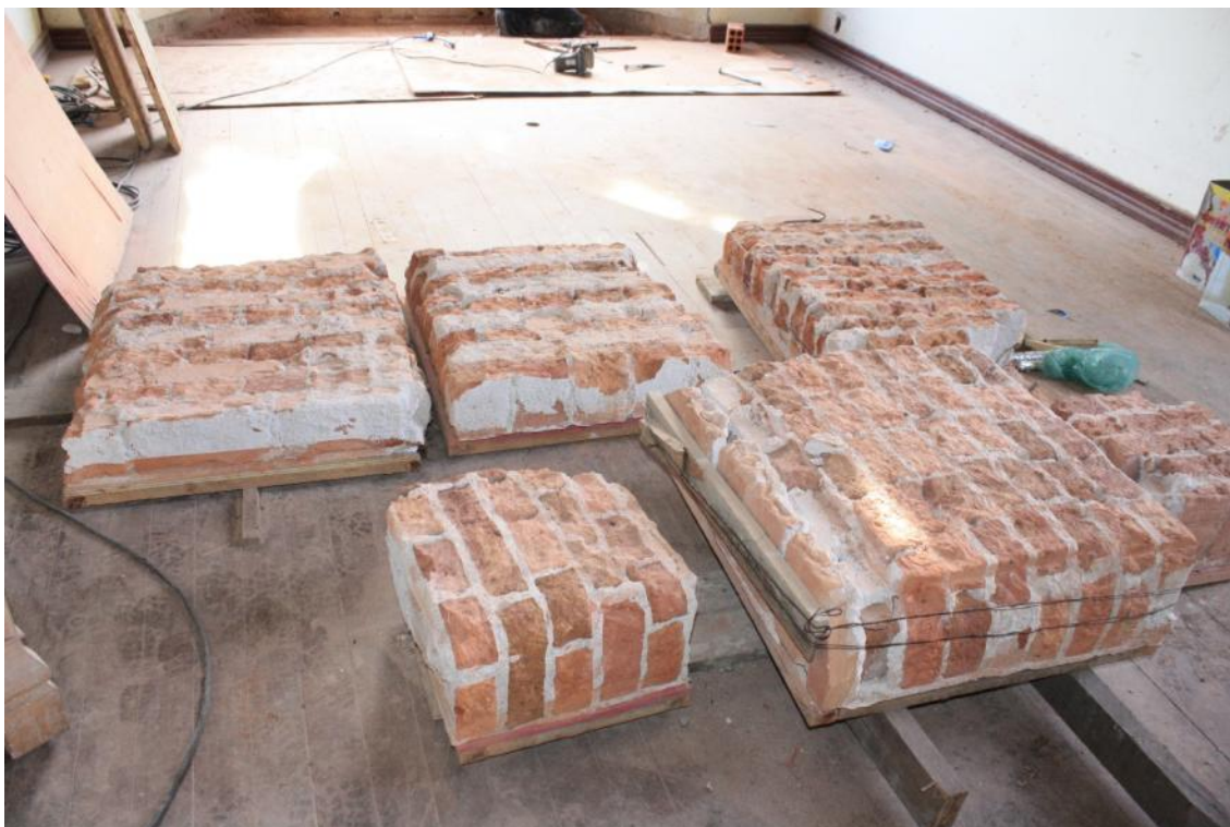
Figura 100: Retirada da imagem de pintura parietal de Nossa Senhora - Residência Vila Sophia Fonte: Autor.
