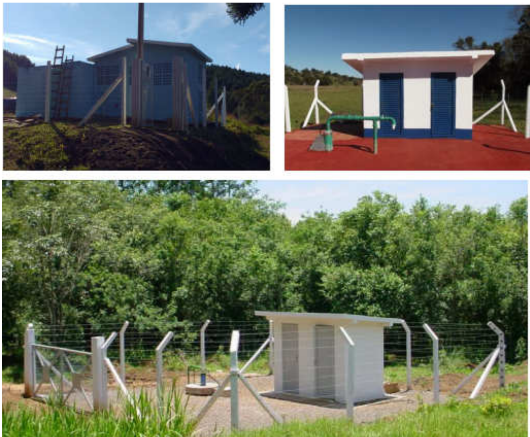
Figura 30 - Modelos de casas de tratamento com poço artesiano
