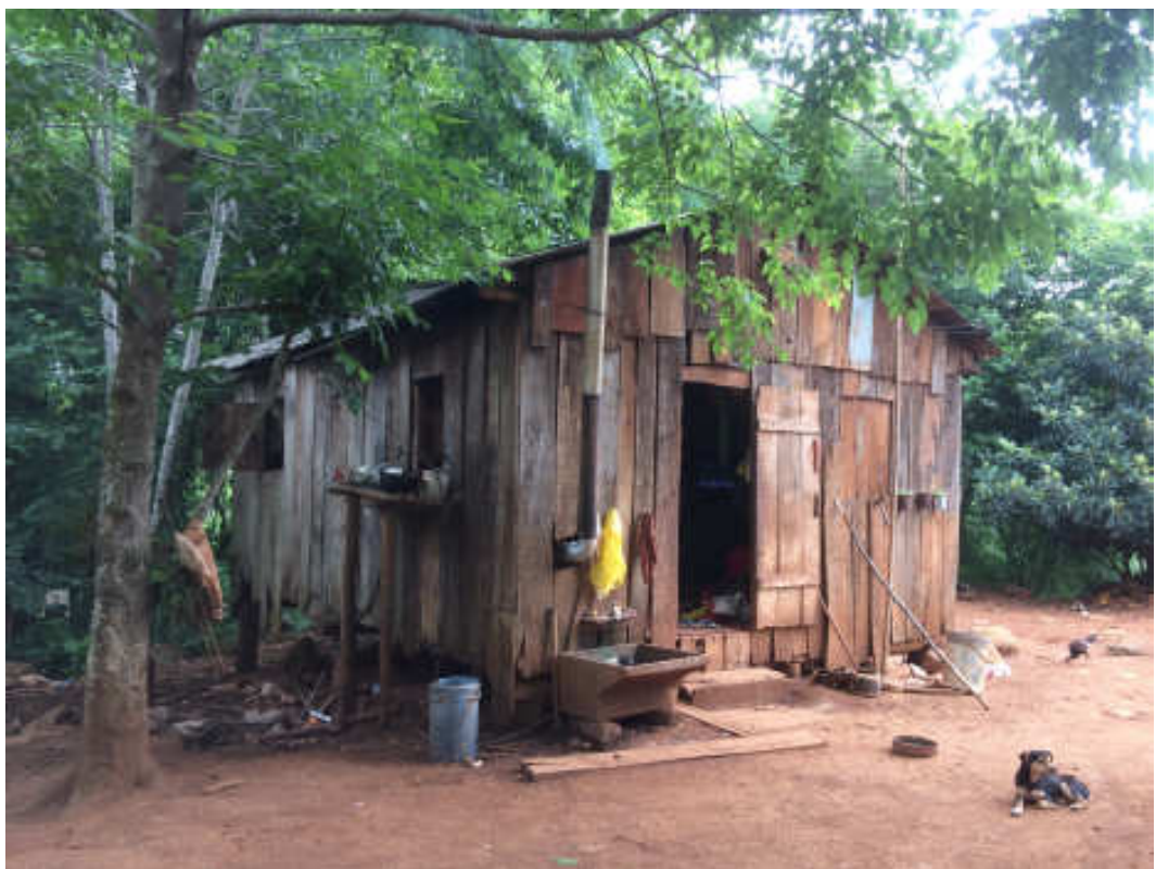
Figura 20 - UH (b) em situação de precariedade
