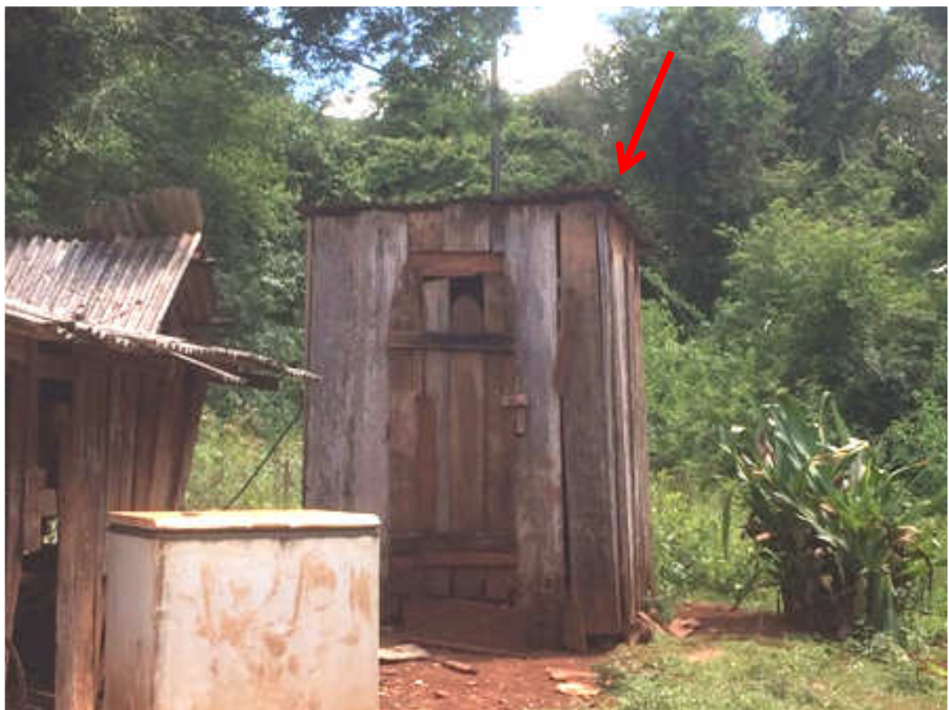
Figura 32 - Banheiro (casinha) utilizado pela UH
