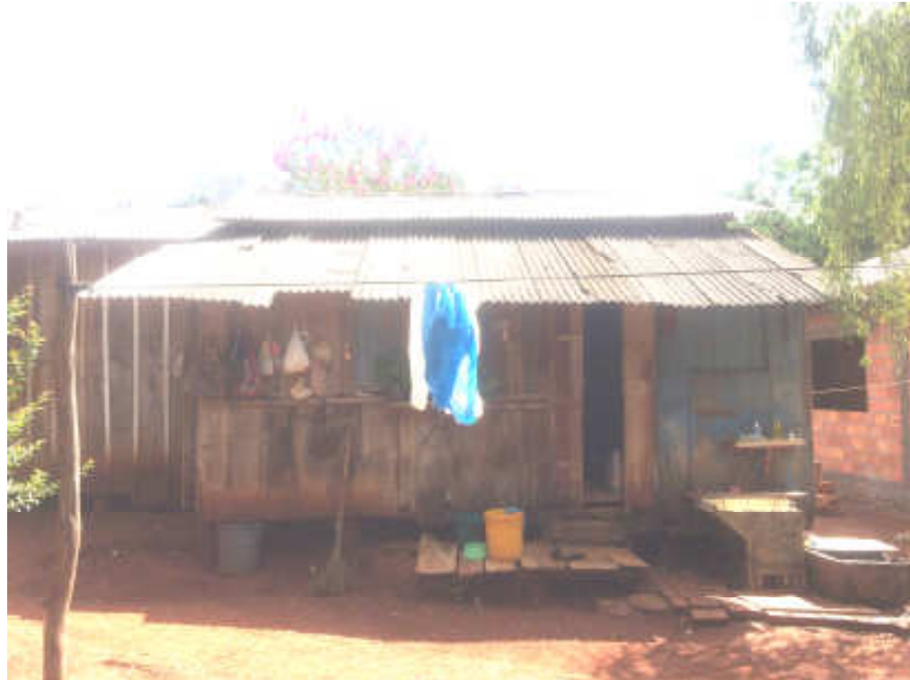
Figura 23 - UH (d) em situação de precariedade
