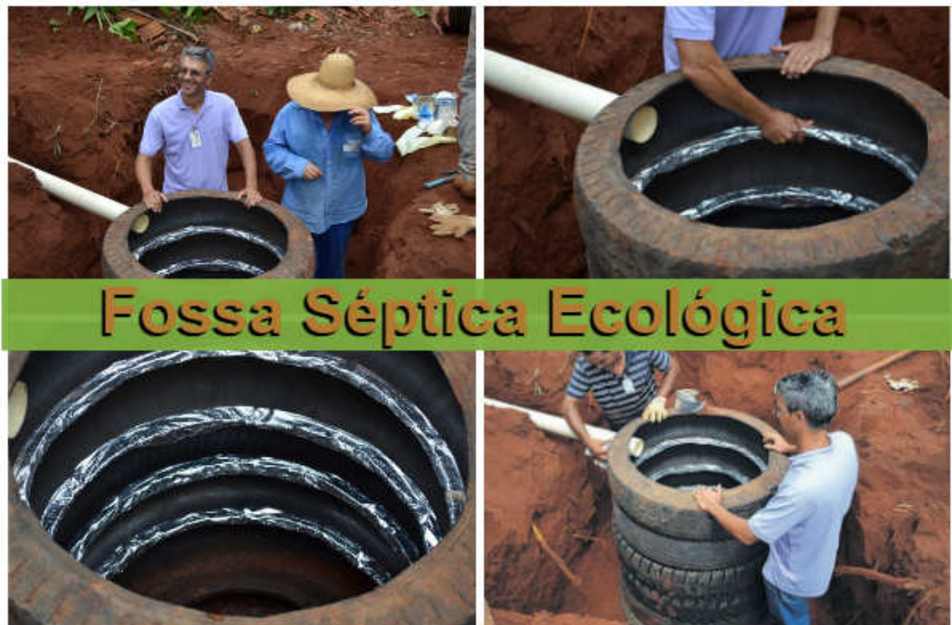
Figura 9 – Modelo de fossa séptica ecológica com o uso de pneus
