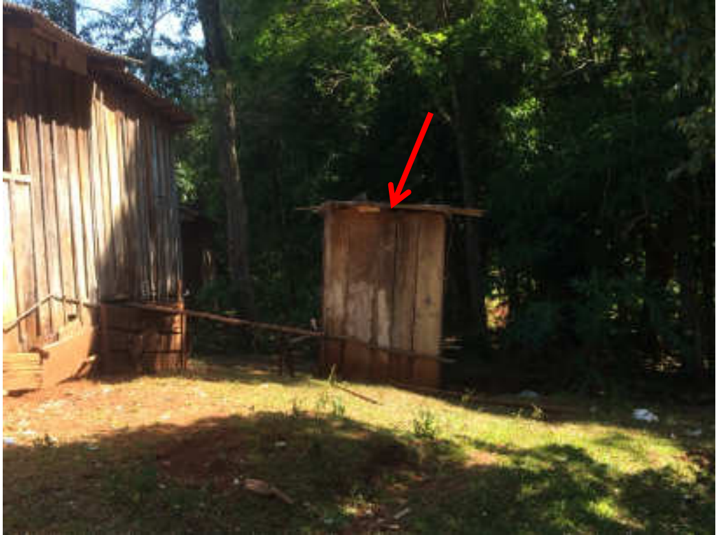
Figura 33 - Banheiro (casinha) utilizado pela UH
