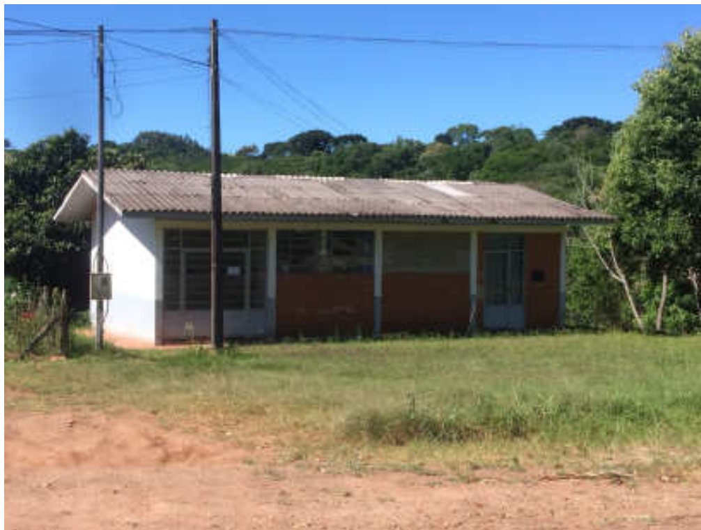
Figura 24 - Posto de saúde na comunidade - Ponte Nova do Cotegipe
