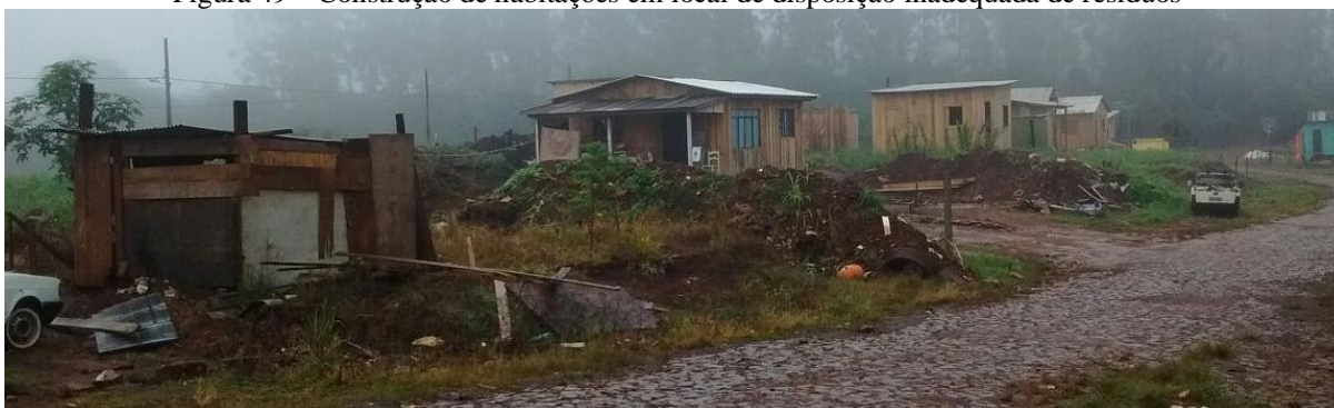
Figura 49 – Construção de habitações em local de disposição inadequada de resíduos
