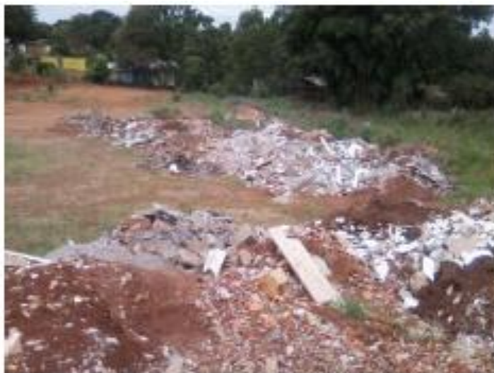
Figura 30 - Nivelamento de terrenos com RCC em Francisco Beltrão
