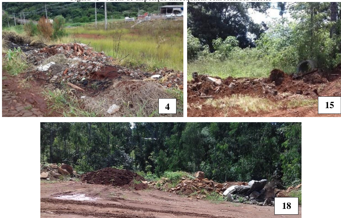
Figura 43 - Áreas de disposição inadequadas com resíduos inertes
