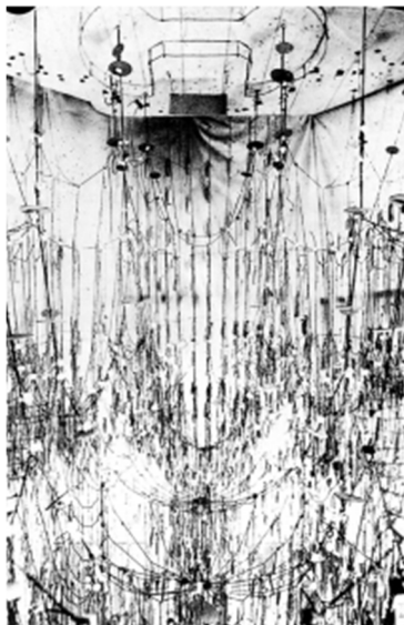
FIGURA 7: Modelo de correntes penduradas de Antoni Galdí para a colônia de Guell. Fonte: NÃO TRIVIAL
