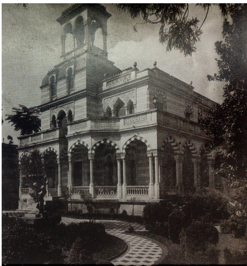
Figura 60. Residência Henrique Schaumann, com a fachada já reformada por Nadim Abrão Andraus (Fonte: TOLEDO, 1987, p. 105).
