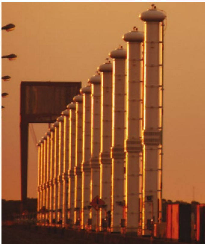
Figura 7 – Pistões de Comportas do sistema de adução
