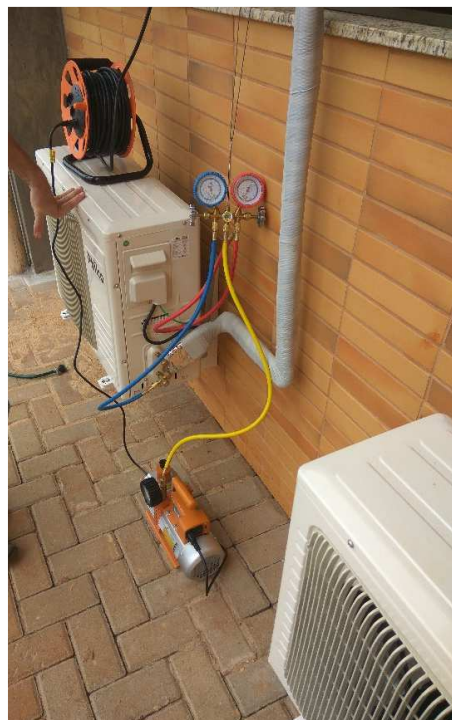
b) Evacuação de ar e umidade do sistema.
