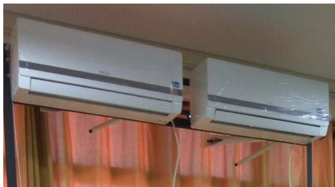
a) Fixação das unidades evaporadoras.
