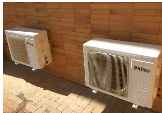
b) Fixação das unidades condensadoras.
