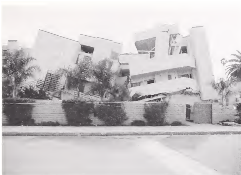
Figura 2 – Edifício Sherman Way em Van Nuys-CA
