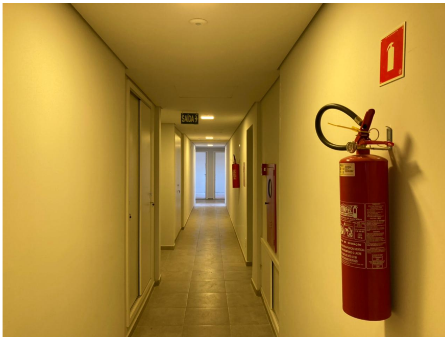
Figura 20 – Caracterização do hall de circulação
