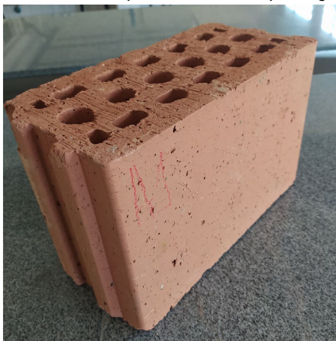
Figura 22 - Bloco utilizado para as divisórias de quartos geminados
