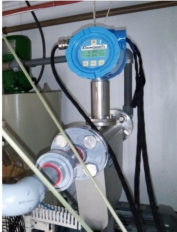
Figura 3.8 - Medidor de vazões do tipo coriolis TCM-5500.
