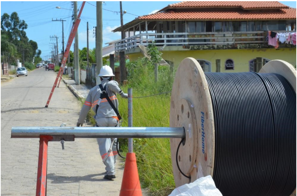
Figura 14 – Técnico desenrolando o cabo óptico para lançamento.
