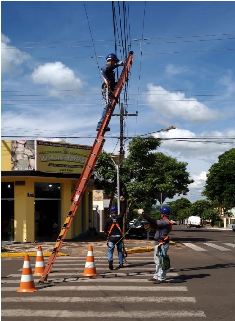
Figura 15 – Técnicos atravessando a fibra óptica entre uma rua.
