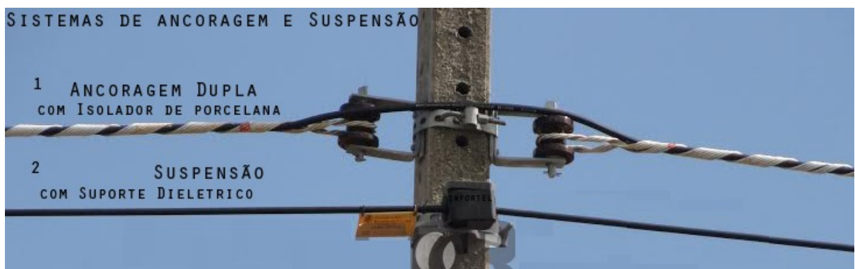
Figura 13 – Exemplo de equipagem de poste
