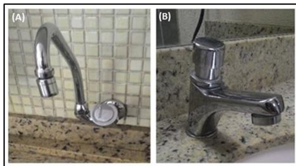
Figura 0-1. A. Torneira convencional; B. Torneira de acionamento/fechamento automático.
