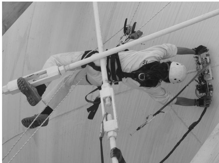
**Figura 1.2:** Inspetor fazendo rapel para inspecionar o tanque.
