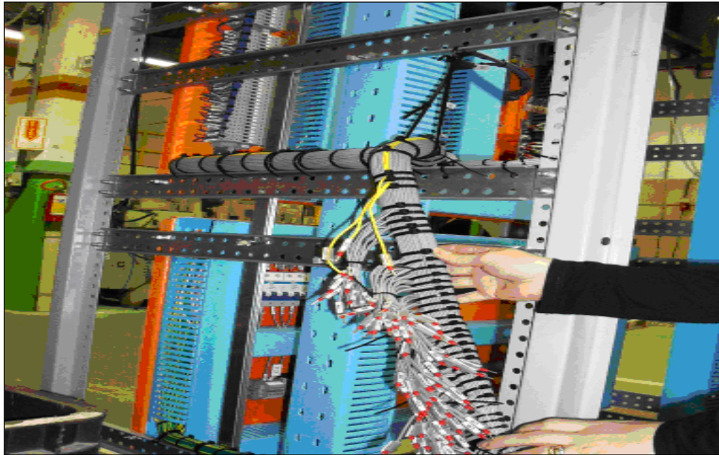
Figura 14: Trabalho de fiação dos painéis
