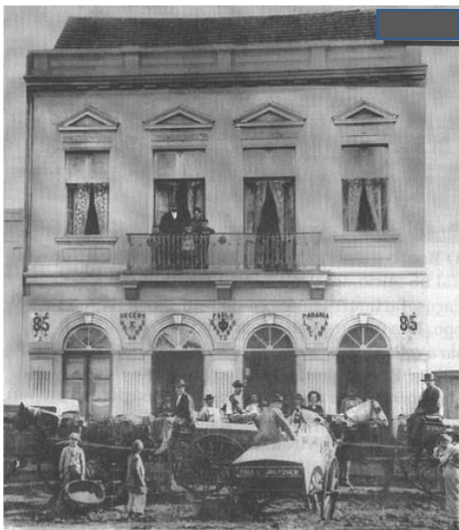
Figura 12: Fachada da Fábrica Lucinda.
