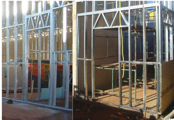
Figura 3 - Interior de painéis steel frame
