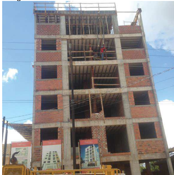
Figura 1 - Sistema construtivo convencional
