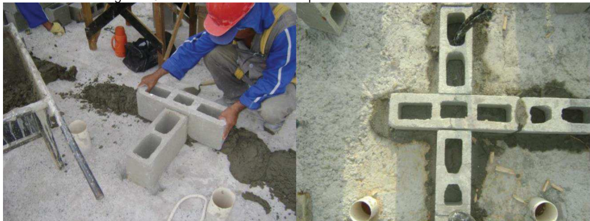
Figura 10 – Encaixe de blocos em paredes de alvenaria estrutural
