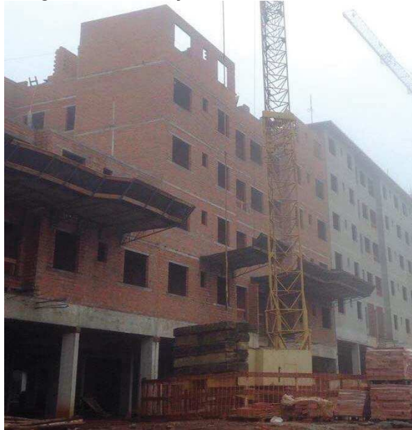
Figura 7 - Construção em alvenaria estrutural
