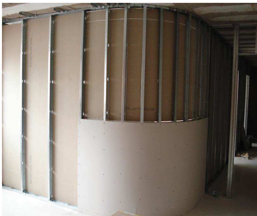
Figura 3 - Parede de gesso acartonado
