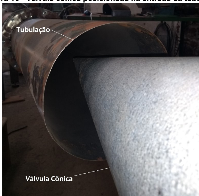
Figura 16 - Válvula cônic posicionada na entrada da tubulação
