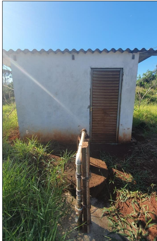
Figura 50 – Estrutura de abastecimento de água da Comunidade da Vila Rural Flor do Campo
