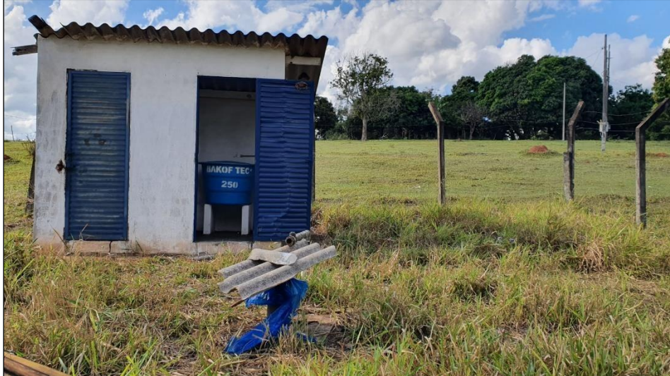
Figura 42 – Poço Artesiano da Comunidade do Km 123
