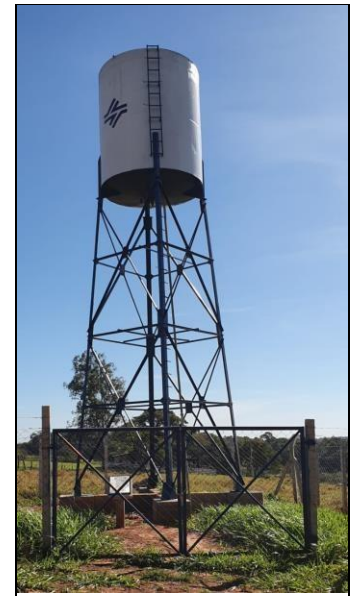
Figura 38 – Estrutura de abastecimento de água da Comunidade da Alto do Divino. (A) Poço artesiano; (B) Reservatório elevado
