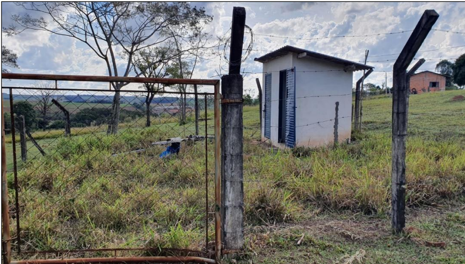
Figura 43 – Poço Artesiano da Comunidade do Km 123
