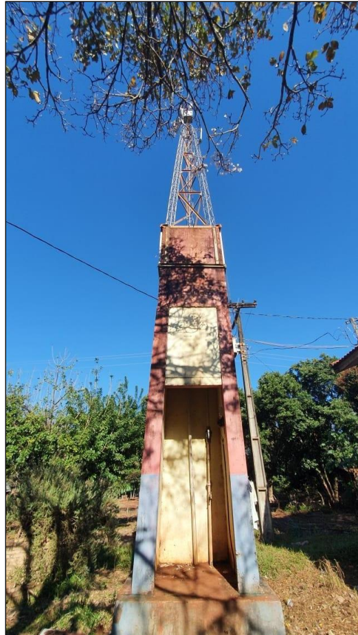
Figura 41 – Armazenamento da água oriunda da mina na Comunidade Boa Esperança
