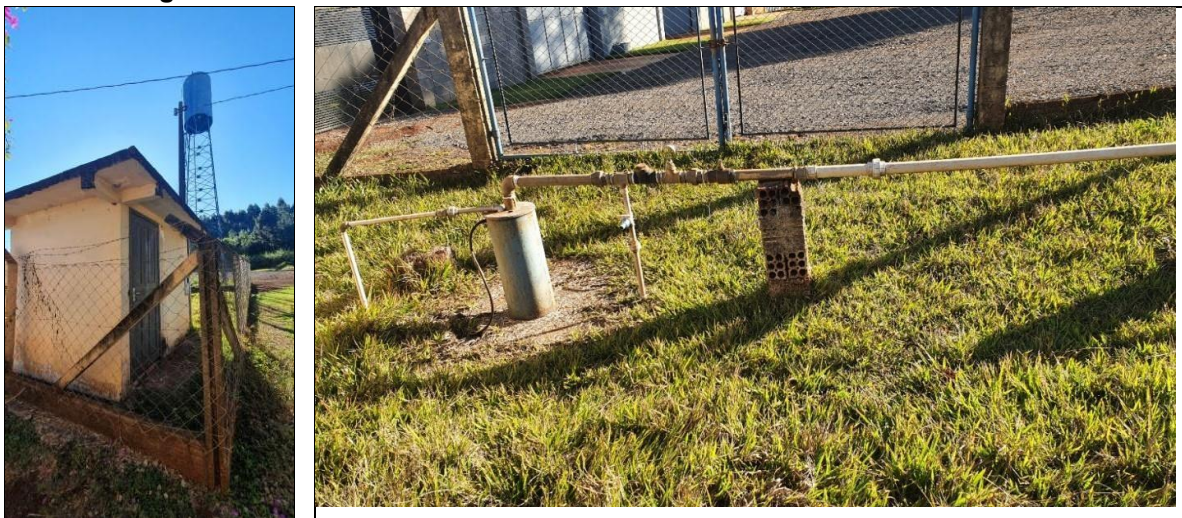
Figura 46 – Estrutura de abastecimento da Comunidade Usina Mourão 1
