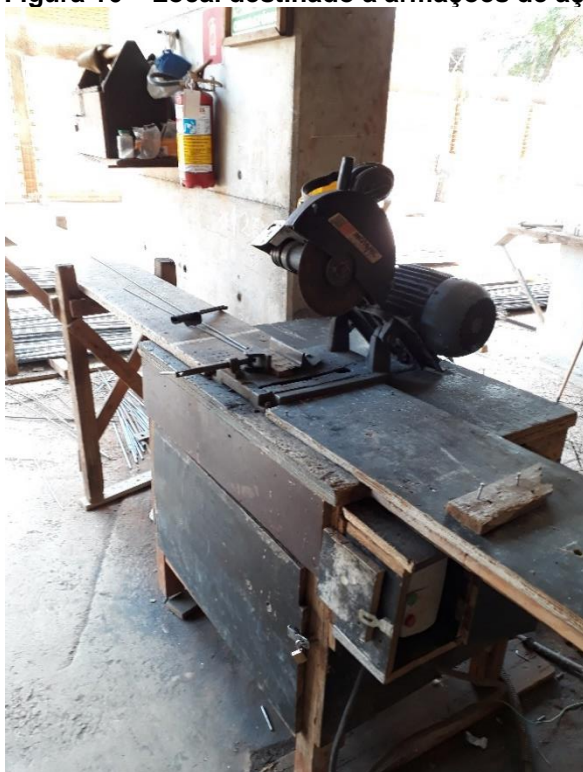
Figura 16 – Local destinado a armações de aço da Obra 2
