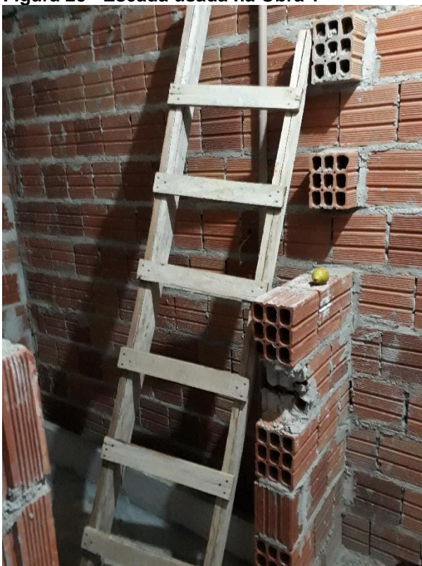
Figura 28 - Escada usada na Obra 1
