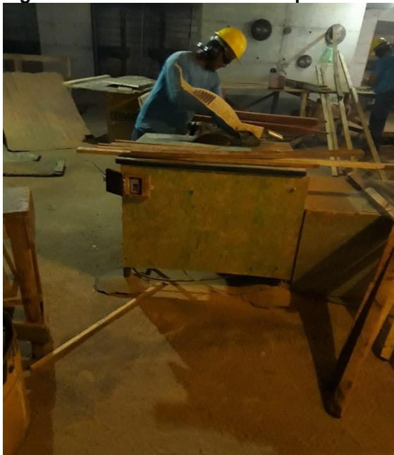
Figura 18 - Local destinado a carpintaria da Obra 2
