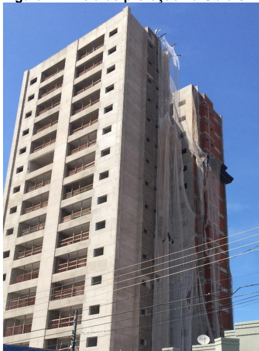
Figura 42 - Tela de proteção na Obra 6
