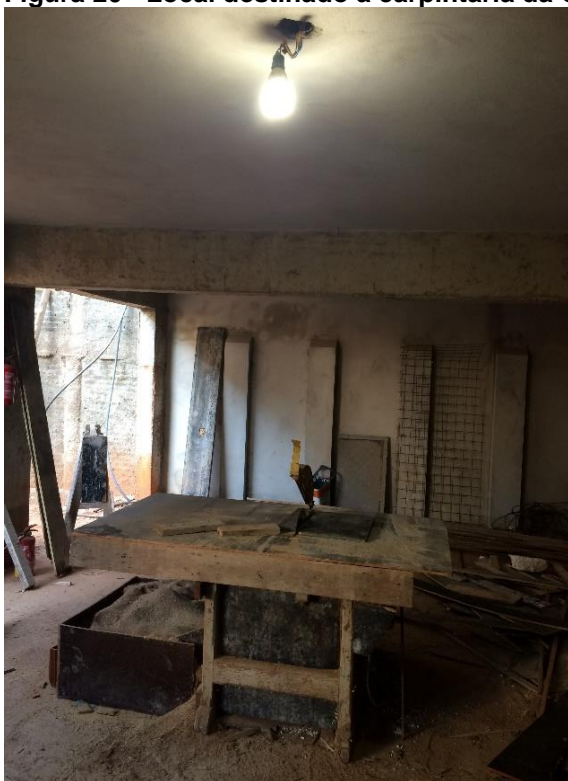
Figura 20 - Local destinado a carpintaria da Obra 6
