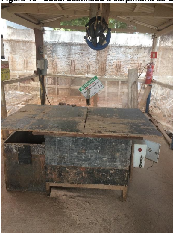
Figura 19 - Local destinado a carpintaria da Obra 5
