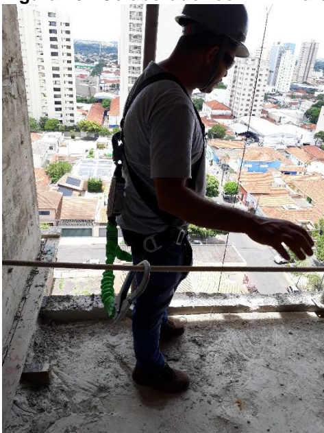
Figura 26 - Colaborador com EPI na Obra 1
