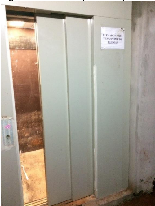
Figura 21 - Elevador para transporte de passageiros da Obra 3
