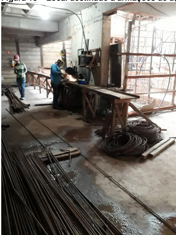
Figura 15 – Local destinado a armações de aço da Obra 1
