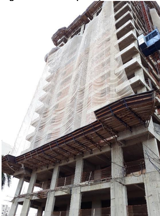
Figura 41 - Tela de proteção na Obra 2
