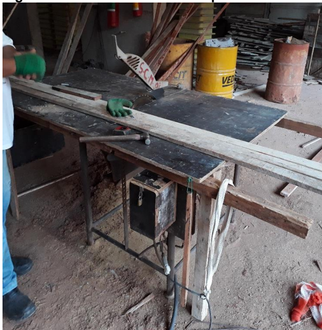
Figura 17 - Local destinado a carpintaria da Obra 1
