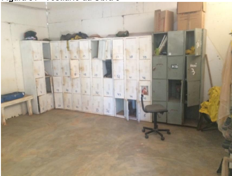
Figura 51 - Vestiário da Obra 5
