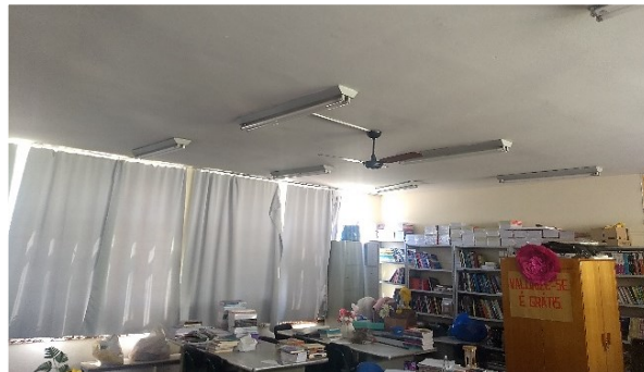
Instalações escola JBA10 Fonte: o autor
