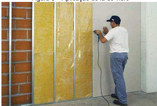
Figura 6 – Aplicação de lã de vidro
