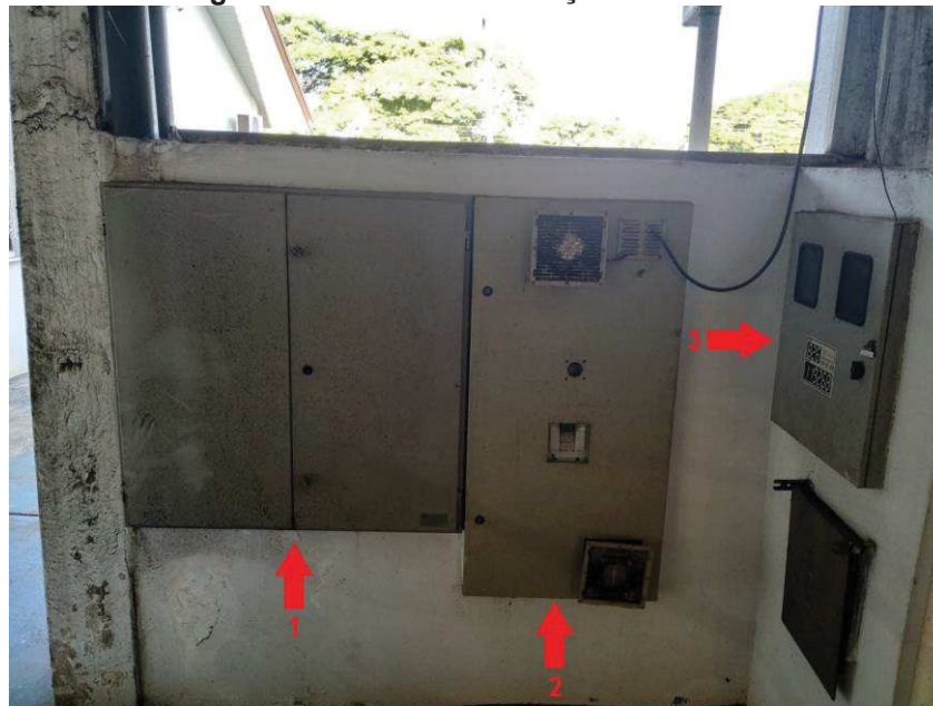
Figura 7 – Entrada de serviço da unidade.
