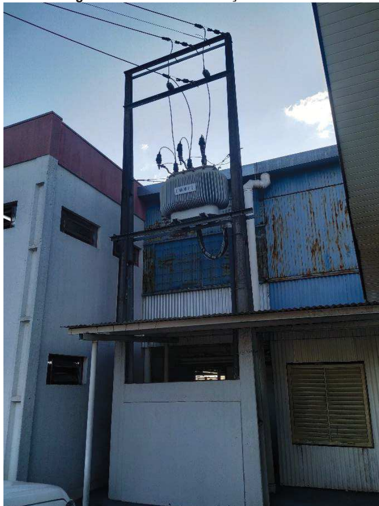
Figura 6 – Entrada de serviço da unidade.
