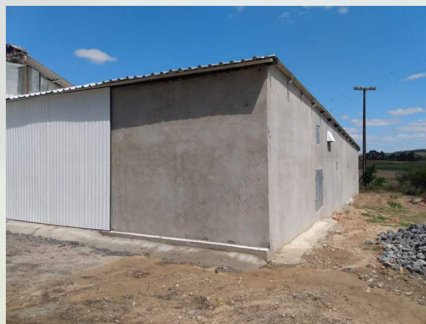
Vista lateral da estufa atual de alvenaria de secagem de Tabaco Fonte: arquivo próprio (2020).
