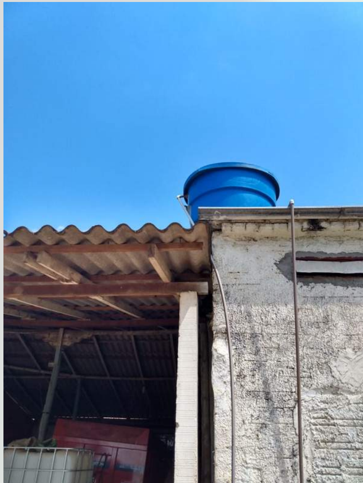
Caixa d'água utilizada para umidificar as folhas de tabaco após a secagem. Fonte: arquivo próprio (2020).
