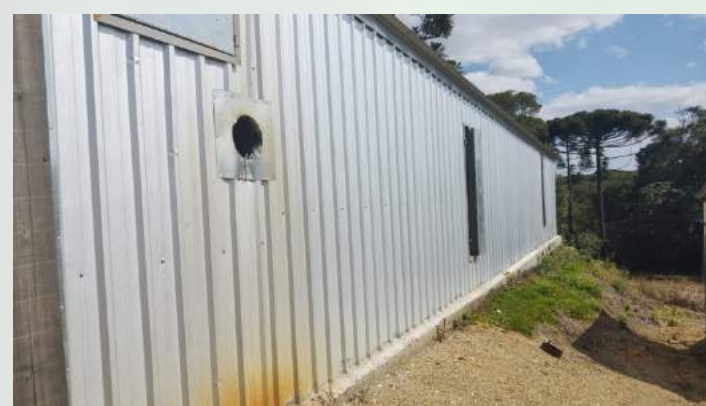
Vista lateral da estufa atual de zinco de secagem de Tabaco Fonte: arquivo próprio (2020).
