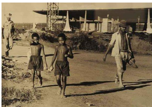
Figura 7 – Trabalhadores no Palácio Alvorada (1956 - 1960)
