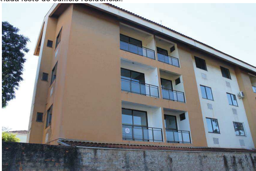
Figura 22 – Fachada leste do edifício residencial.
