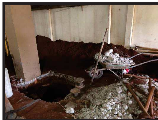
(b) abertura para realizar o reforço
