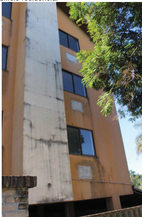
Figura 20 – Fachada sul do edifício residencial
