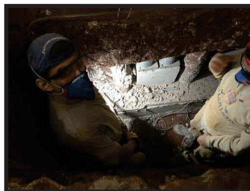
(b) profissionais realizando o reforço de fundação.
