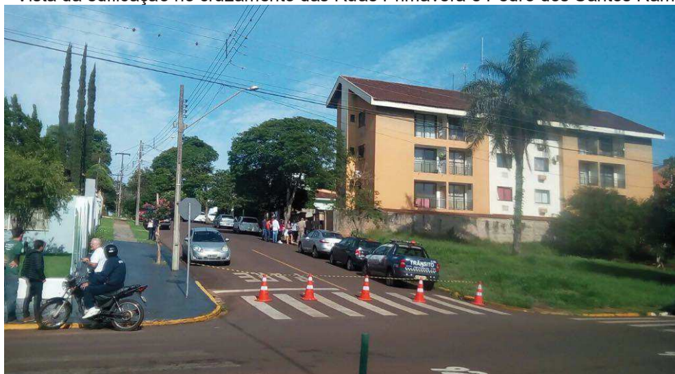
Figura 9 – Vista da edificação no cruzamento das Ruas Primavera e Pedro dos Santos Ramos
