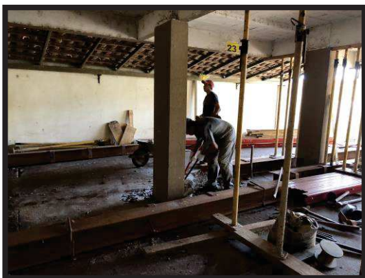
Figura 27 – Abertura para realizar o reforço
