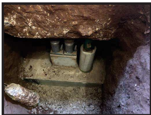
Figura 29 – Reforço de fundação
