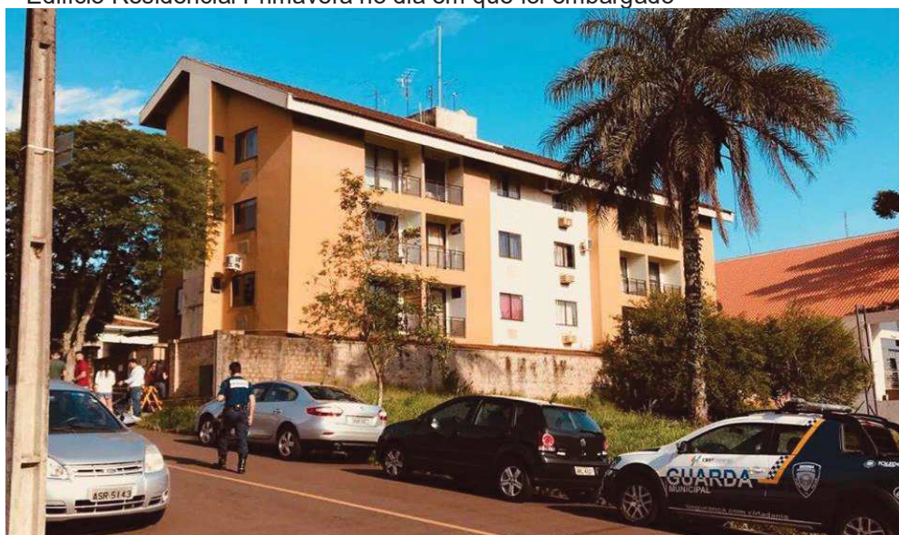
Figura 8 – Edifício Residencial Primavera no dia em que foi embargado
