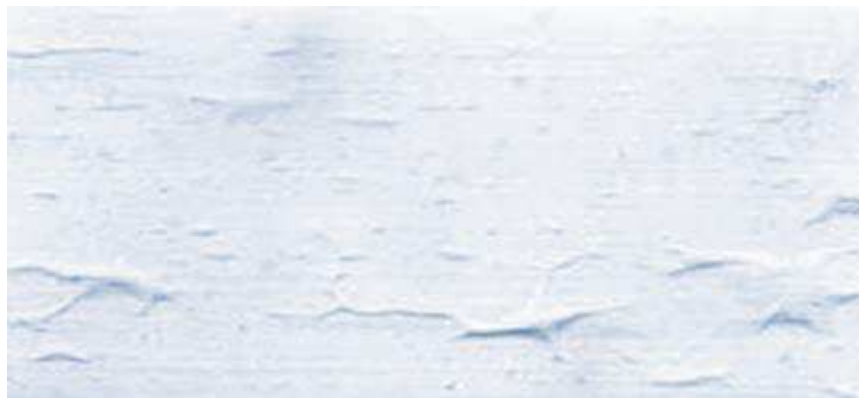
Figura 6 - Enrugamento da tinta após aplicação na parede.
