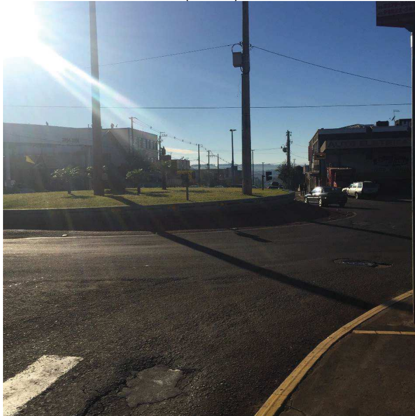
Figura 27 – Visibilidade comprometida do anel pelo acesso da Avenida Maripá (centro)
