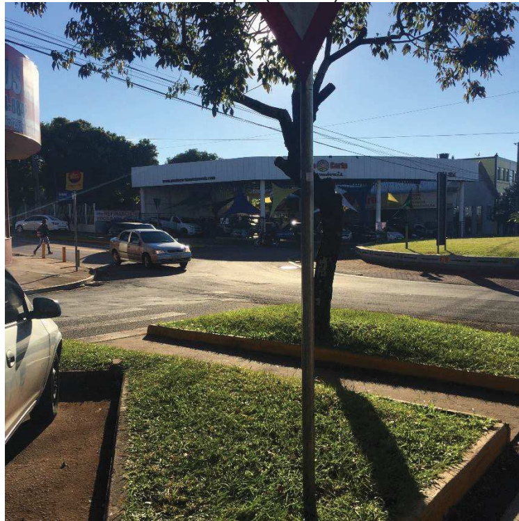
Figura 28 – Visibilidade comprometida do critério de parada pelo acesso da Avenida Maripá (centro)
