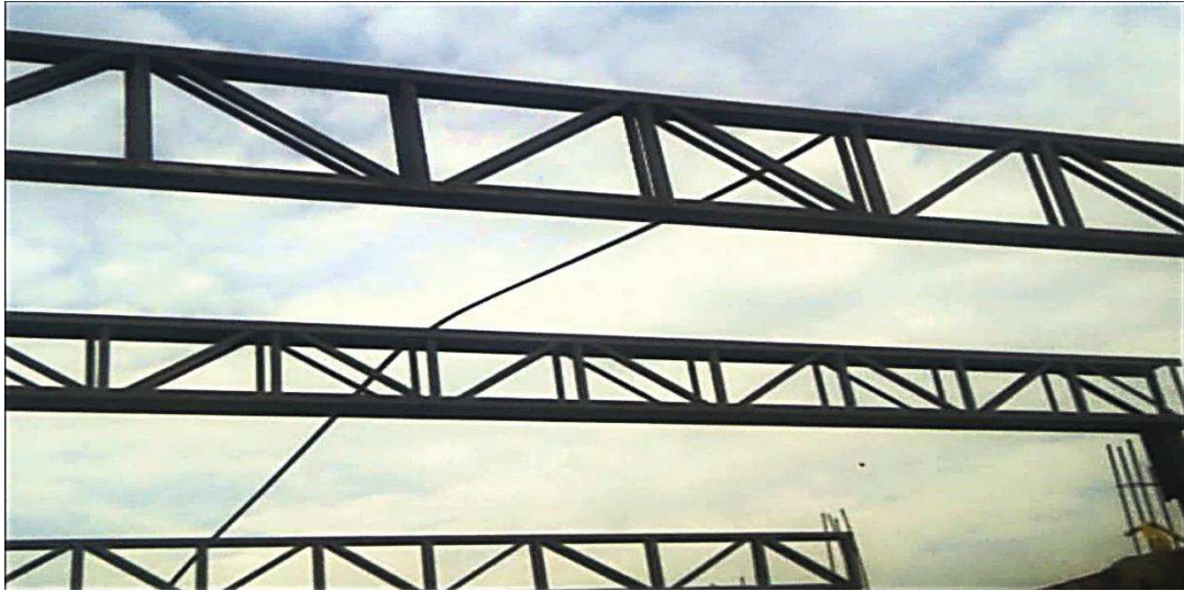
Figura 25 – Treliça com configuração comumente utilizada.
