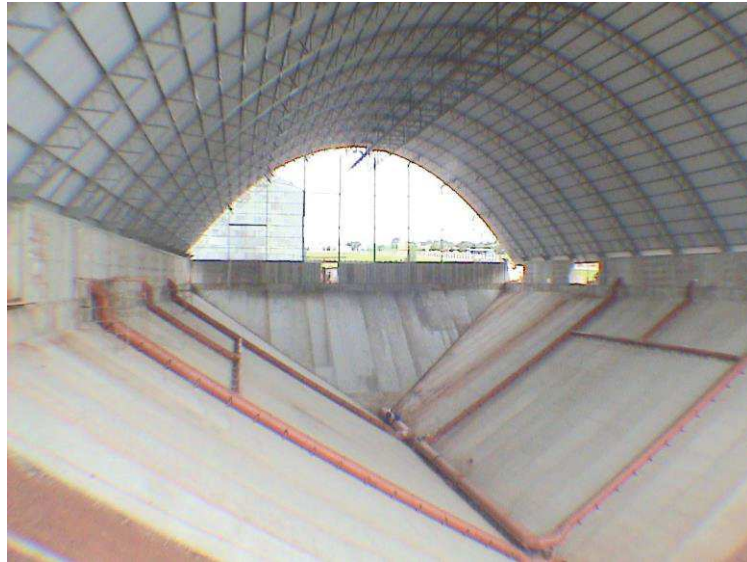
Figura 1: Armazém graneleiro de fundo V Fonte: Sul estruturas (2015).
