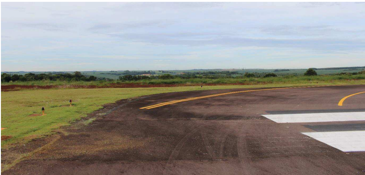
Figura 84- Crescimento de gramíneas nas bordas da pista e da cabeceira.
