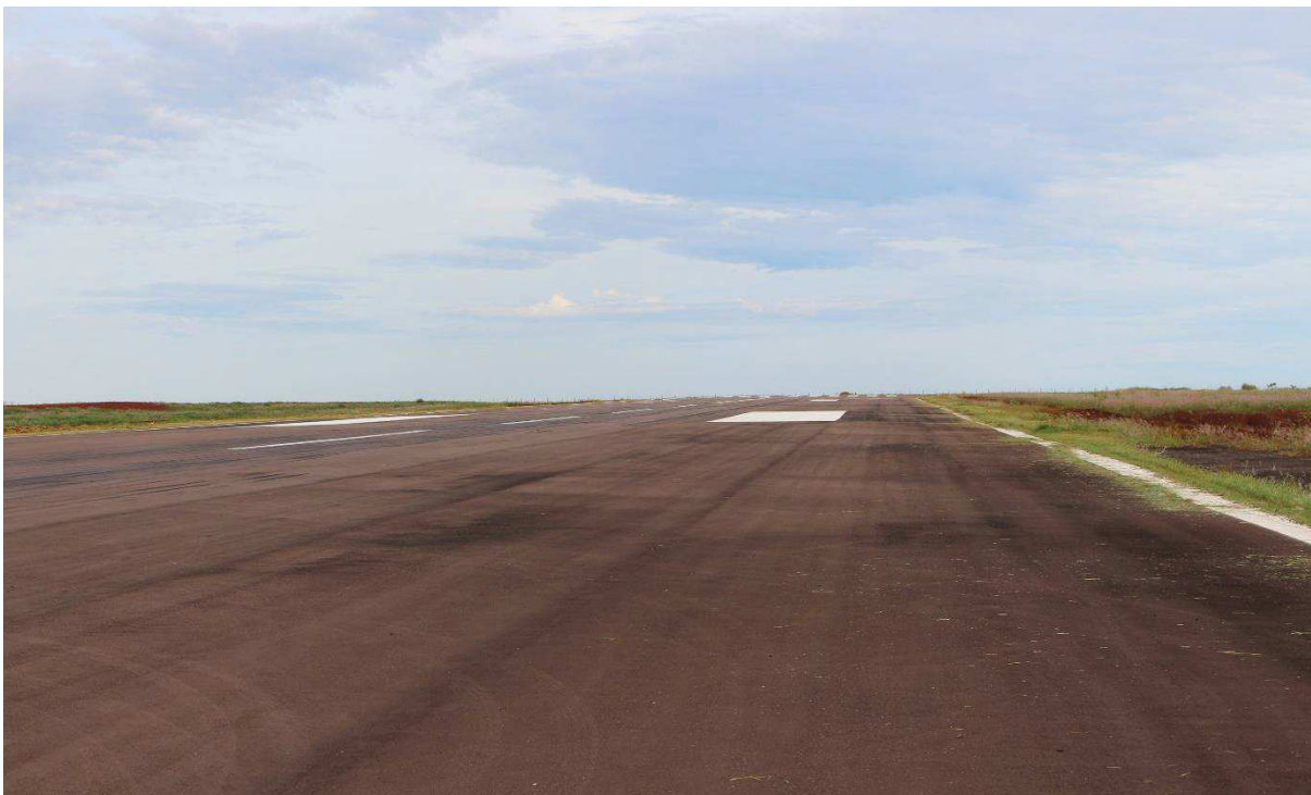
Figura 80- Pavimento do aeroporto em bom estado de conservação
