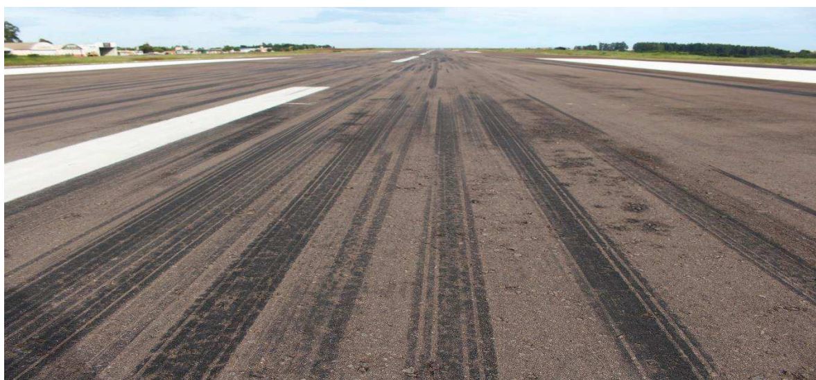
Figura 88- Apesar das marcas de Frenagens, não há acúmulo de borracha visualmente na pista.
