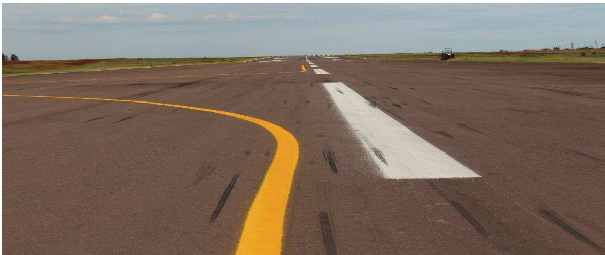
Figura 90- Pintura e marcação do eixo da pista e acesso a taxiway
