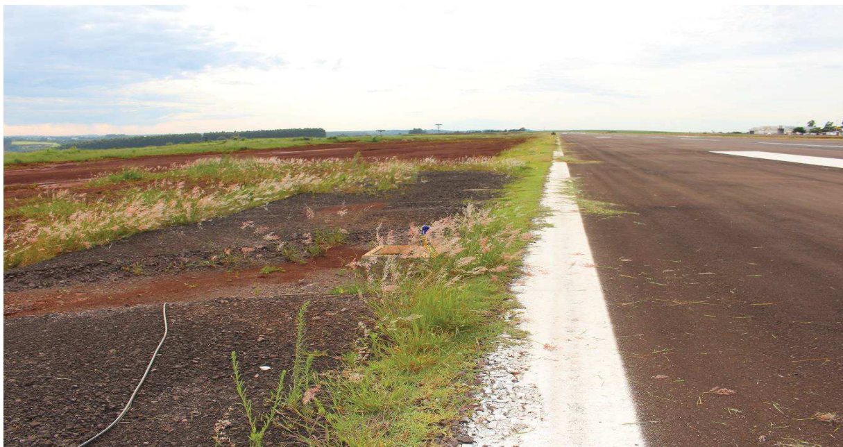
Figura 93- Pintura e marcação da borda da pista de pouso e decolagem.
