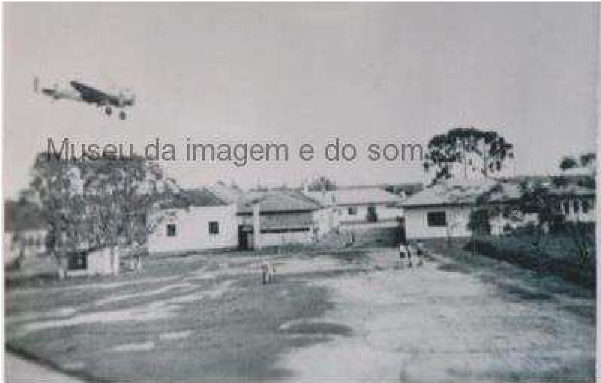
Figura 9 - Pista de pouso local que se localiza a atual Praça do Migrante. Fonte: MIS (2017)
