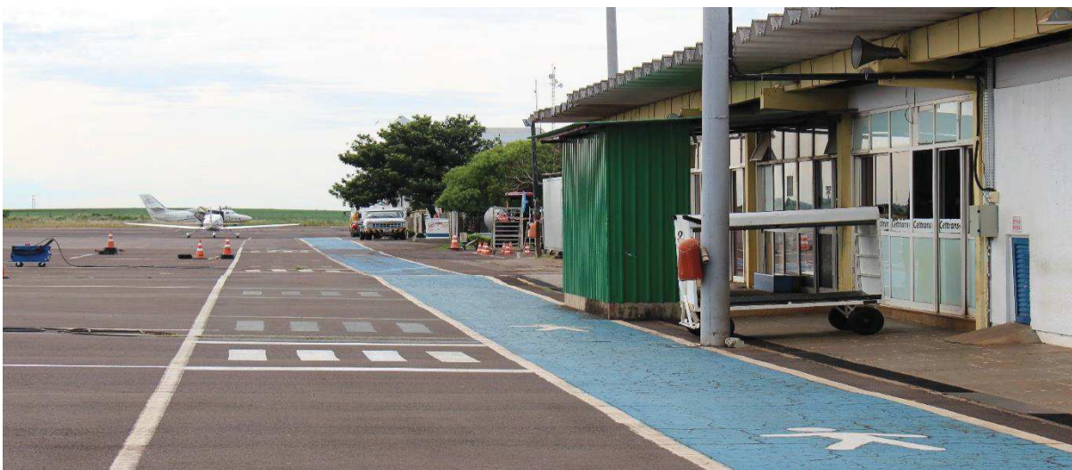
Figura 92- Pintura e marcação do acesso ao Terminal de passageiros e Pátio de Aeronaves.
