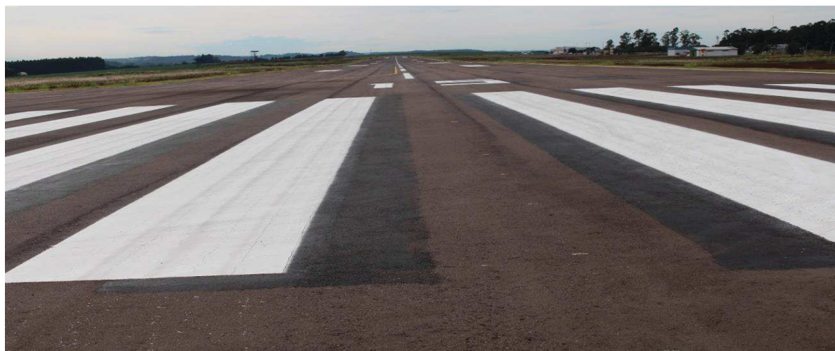
Figura 91- Pintura e marcação da Cabeceira 15
