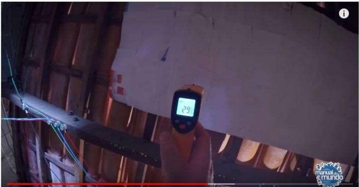
Figura 6. Medição da temperatura após instalação da manta térmica
