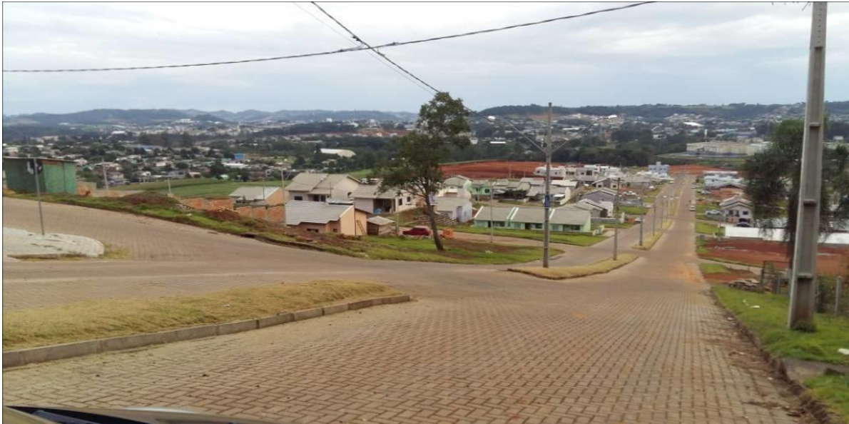
Figura 04- Vista da área mais alta do Loteamento Marchiori
