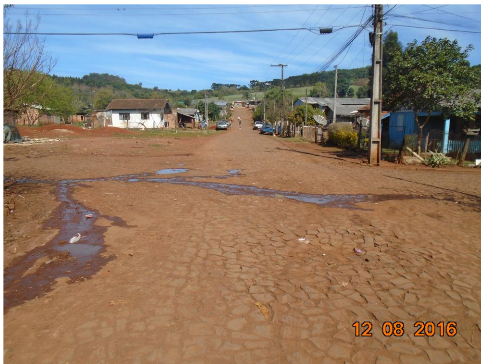
Figura 20: Fotografia do Bairro São João - Rua Sadi Bertol – Ausência de calçadas e presença de esgoto a céu aberto
