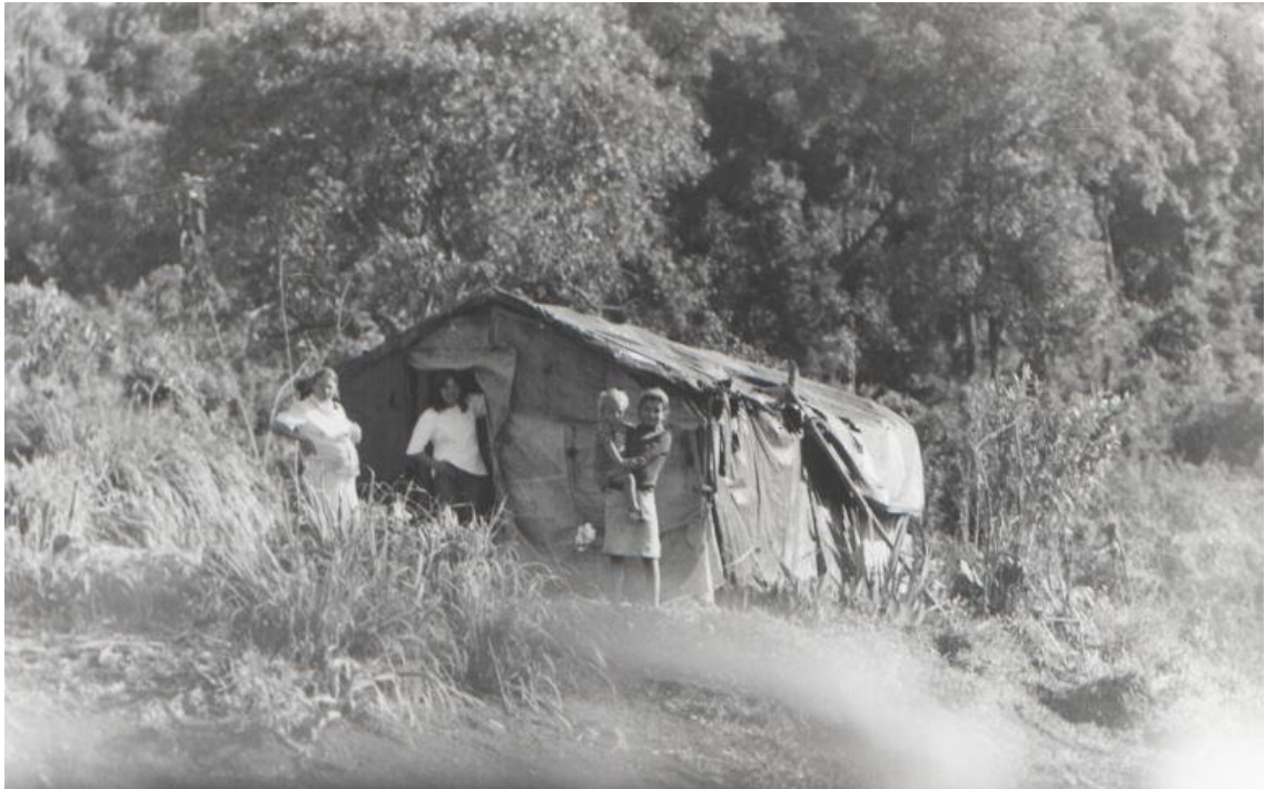
Figura 3: Fotografia da residência de uma família do bairro São João Fonte: Acervo Convento Santo Antônio de Pádua (Década de 80)/PIZATO (2016)
