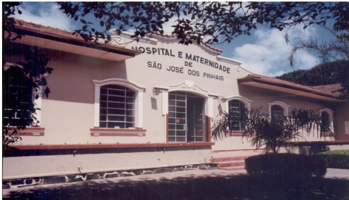
FOTOGRAFIA 06 – Edifício original do Hospital e Maternidade de São José dos Pinhais – data desconhecida. (Foto: autor desconhecido).
