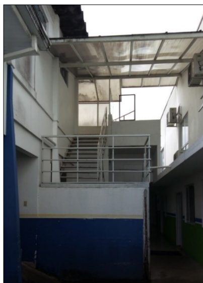
FOTOGRAFIA 10 – Acesso à instalação sanitária coletiva do HMSJP.
