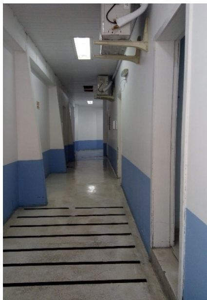
FOTOGRAFIA 09 – Circulação lateral ao centro cirúrgico/obstétrico.
