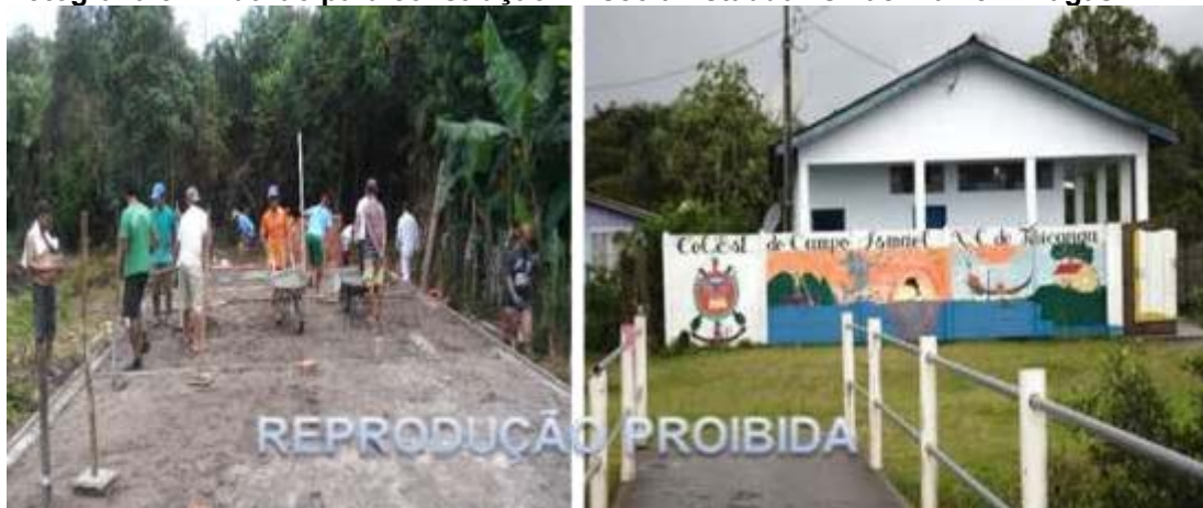
Fotografia 5 – Mutirão para construção – Escola Estadual Ismael Xavier Chagas
