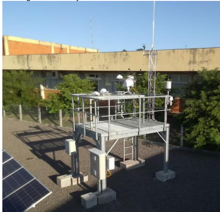
Figura 45 - Estação SONDA instalada em Medianeira
